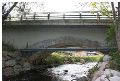
Pont de la Glières, face amont Phot. Benoît Huraut IVR84_20207400973NUCA
