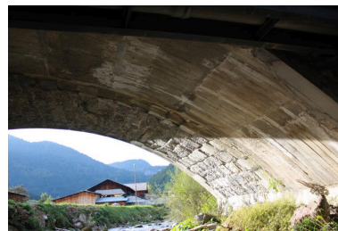
Pont de la Glières, détail intrados Phot. Benoît Huraut IVR84_20207400975NUCA
