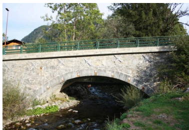
Pont de la Glières, face aval Phot. Benoît Huraut IVR84_20207400974NUCA
