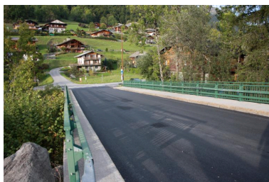
Pont de la Glière, contexte, chaussée et garde corps Phot. Benoît Huraut IVR84_20207400977NUCA
