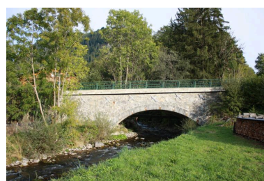
Vue générale du pont de la Glières IVR84_20197401262NUCA
