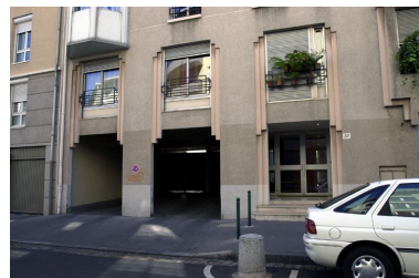
Elévation antérieure, détail des ouvertures (porte d'entrée et accès aux garages) Phot. Maryannick Chalabi IVR82_20096901355NUCA
