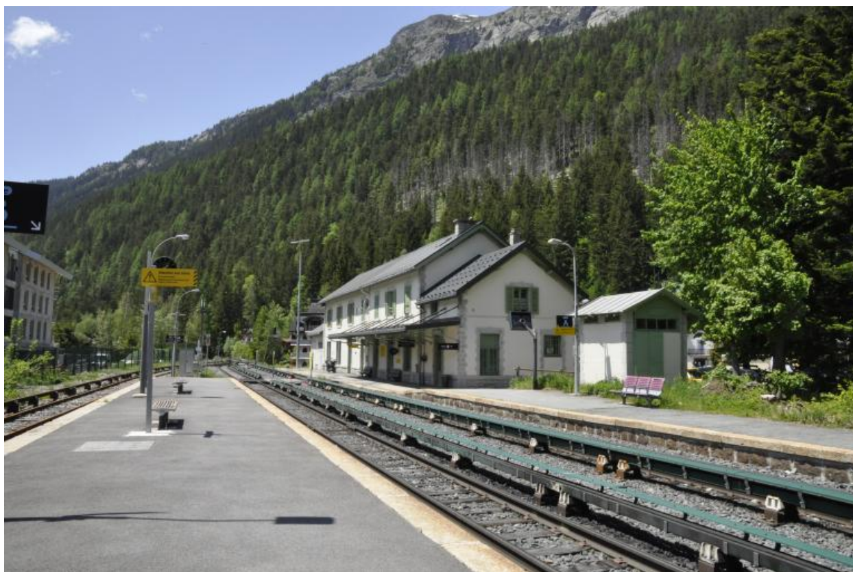
Vue de l'élévation sud-est du bâtiment de la gare d'Argentière prise depuis le quai central
