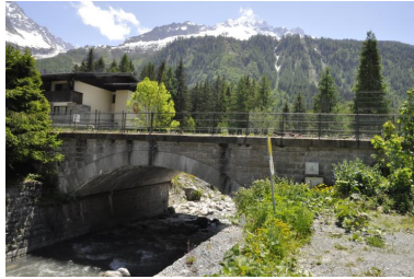
Vue de la face amont du pont Phot. Samir Mahfoudi IVR84_20207401133NUCA
