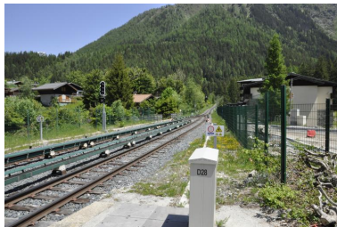
Détail des voies ferroviaires empruntant le pont Phot. Samir Mahfoudi IVR84_20207401136NUCA
