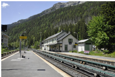
Vue de l'élévation sud-est du bâtiment de la gare d'Argentière prise depuis le quai central Phot. Samir Mahfoudi IVR84_20207401135NUCA
