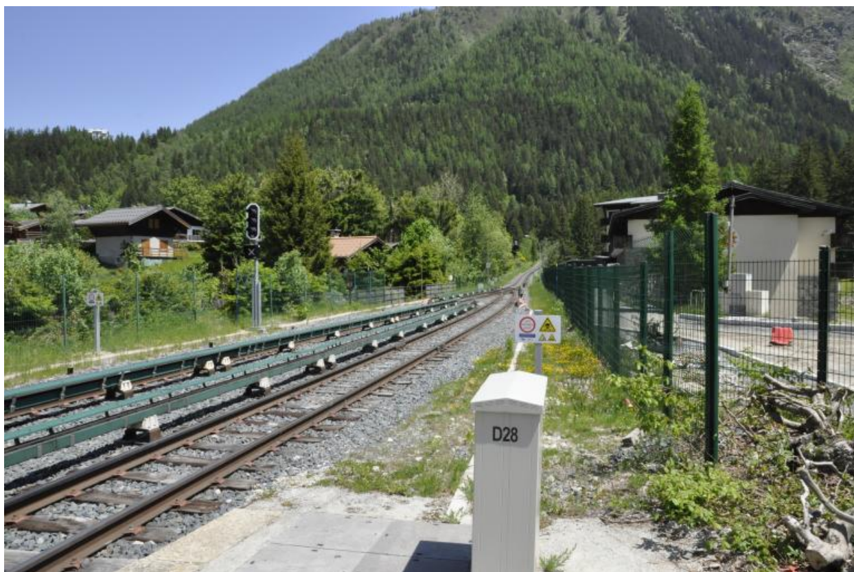
Détail des voies ferroviaires empruntant le pont
