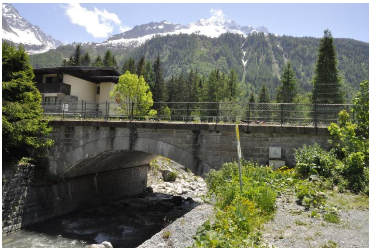
Vue de la face amont du pont
