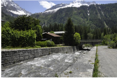
Vue des digues et des seuils canalisant le cours de l'Arve en amont du pont ferroviaire Phot. Samir Mahfoudi IVR84_20207401131NUCA
