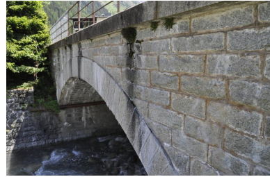
Détail du tympan amont et du bandeau de la voûte Phot. Samir Mahfoudi IVR84_20207401134NUCA
