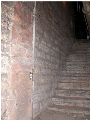
Escalier d'accès aux caves Phot. Maryannick Chalabi IVR82_20046904555NUCA
