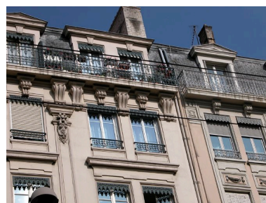
Détail du balcon filant du dernier niveau : prolongement entre les n° 10 et 12 avenue Jean-Jaurès Phot. Maryannick Chalabi IVR82_20046904570NUCA
