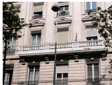
Détail du balcon à balustres du 1er étage Phot. Maryannick Chalabi IVR82_20046904545NUCA
