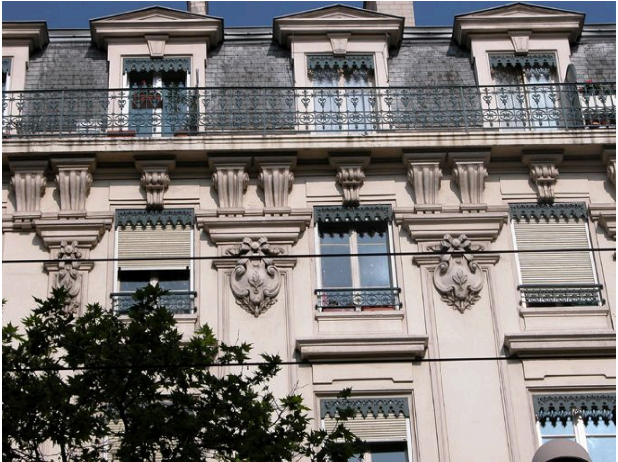
Détail du balcon filant et du décor sculpté du 5e niveau
