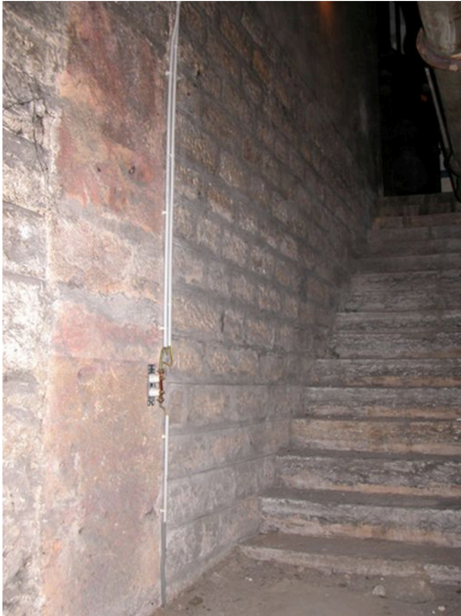
Escalier d'accès aux caves
