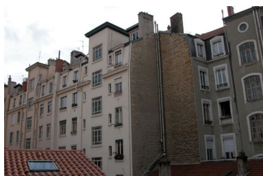
Elévation postérieure Phot. Maryannick Chalabi IVR82_20046904611NUCA
