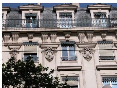
Détail du balcon filant et du décor sculpté du 5e niveau Phot. Maryannick Chalabi IVR82_20046904546NUCA
