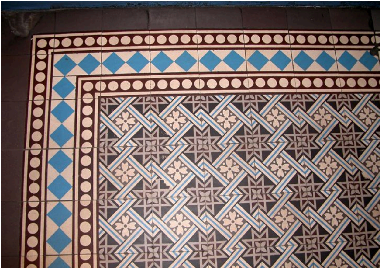
Carrelage en ciment moulé du vestibule
