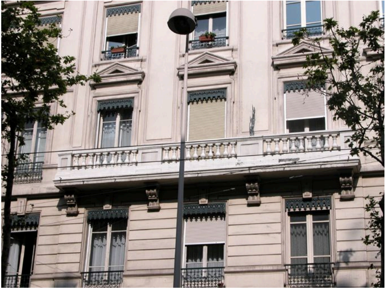
Détail du balcon à balustres du 1er étage
