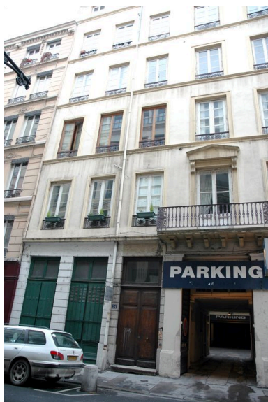
Elévation antérieure Phot. Catherine Guégan IVR82_20076900015NUCA
