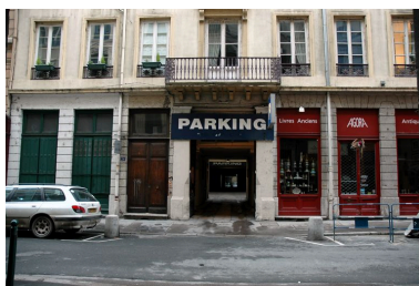
Elévation antérieure : rez- de-chaussée avec boutiques Phot. Catherine Guégan IVR82_20076900016NUCA
