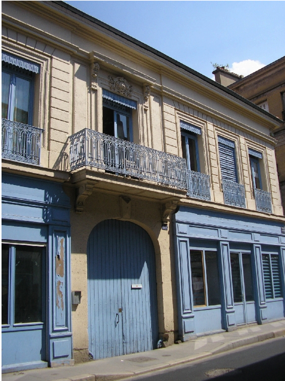
Détail de la travée centrale
