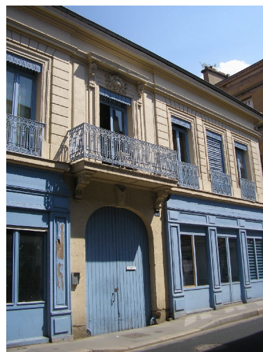
Détail de la travée centrale Phot. Cendrine Sanquer IVR82_20084200531NUCA
