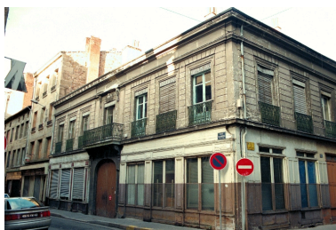
Vue d'ensemble. Etat en 1996 Phot. Cendrine Sanquer IVR82_19974201853ZE
