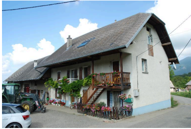
Vue d'ensemble. Phot. Thierry Monnet IVR84_20167304653NUCA
