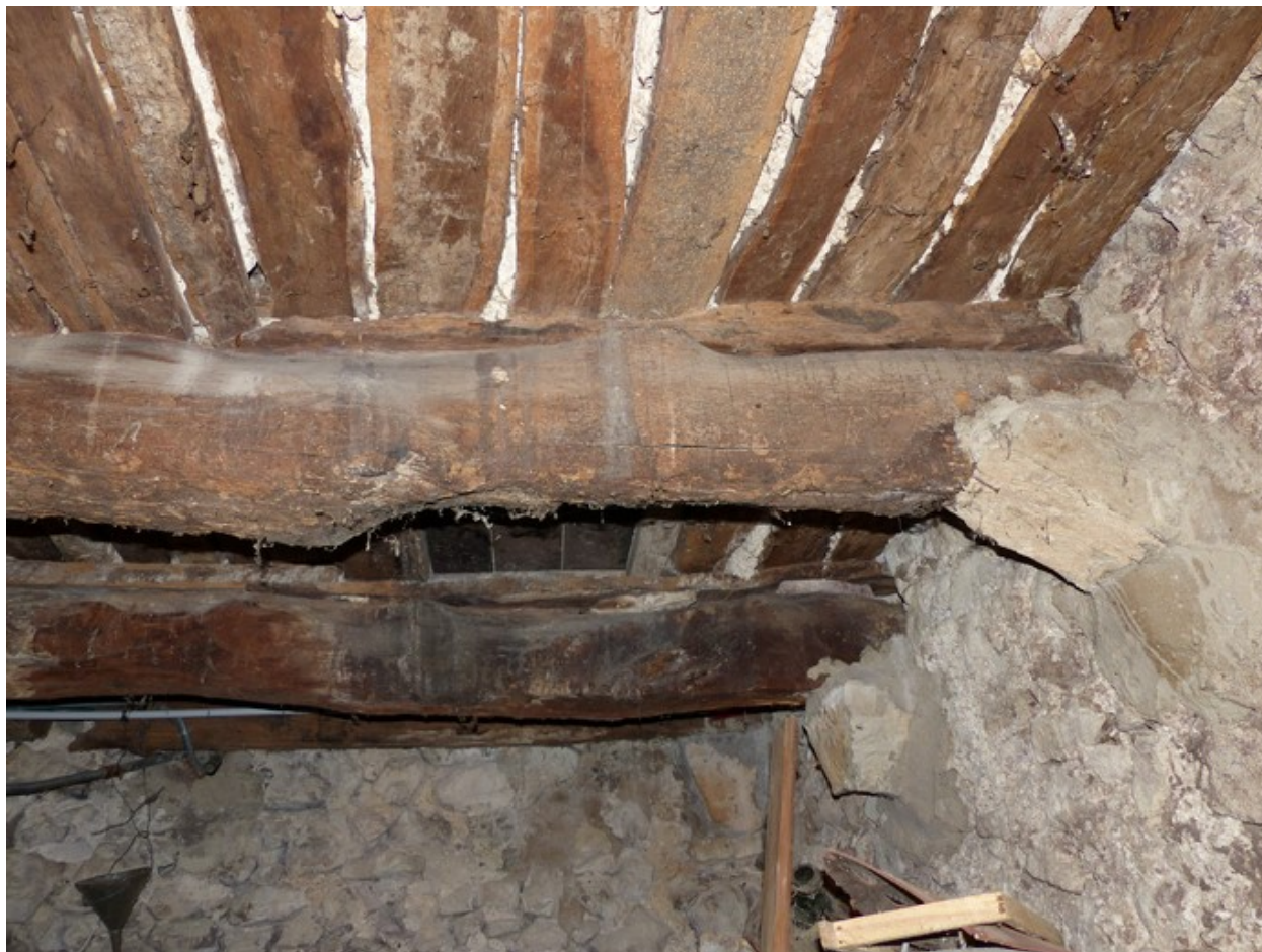
Bâtiment du logis. Etage de soubassement, cellier nord. Mur est, corbeaux maçonnés supportant les solives.
