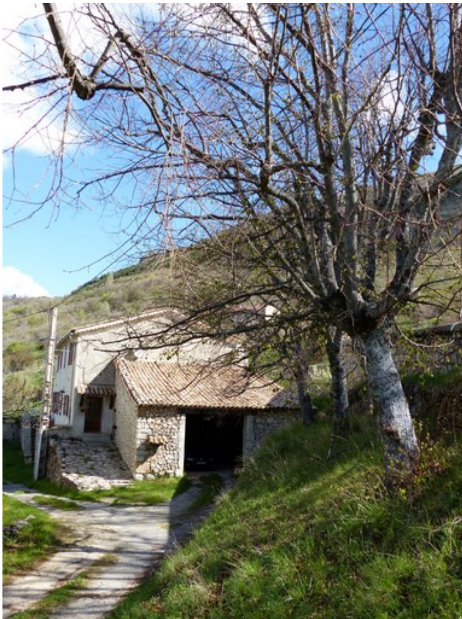
Allée de tilleuls, vue prise du sud.
