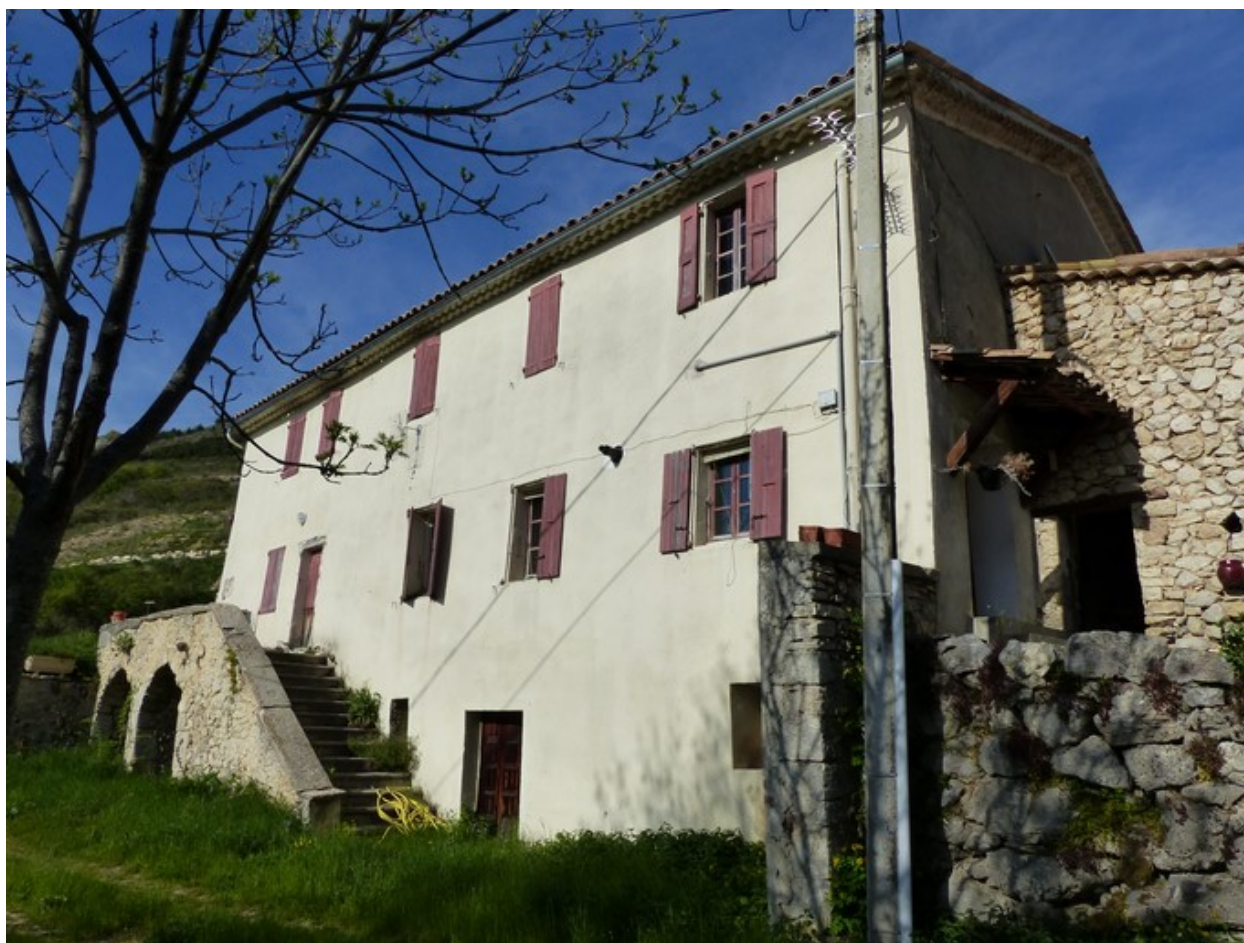
Bâtiment principal. Vue d'ensemble prise du sud-ouest.
