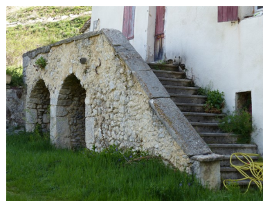
Bâtiment du logis. Elévation ouest, premier niveau. Escalier extérieur et palier filant sur deux voûtes en berceau. Phot. Alexeï Laurent IVR84_20162600555NUCA
