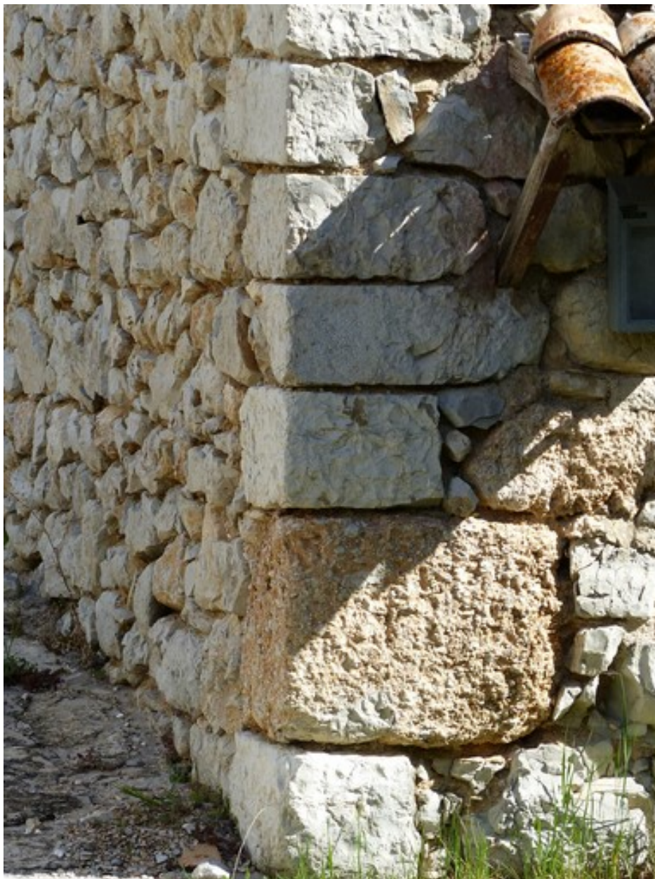
Bâtiment de la remise. Chaîne d'angle sud-ouest, en pierre de taille calcaire et de brèche calcaire.
