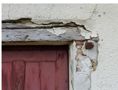
Bâtiment du logis. Elévation ouest, deuxième niveau. Porte, détail de l'encadrement. Phot. Alexeï Laurent IVR84_20162600560NUCA
