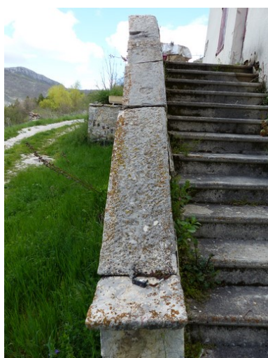
Bâtiment du logis. Escalier extérieur, main courante en pierre de taille. Phot. Alexeï Laurent IVR84_20162600559NUCA
