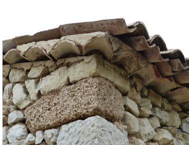
Bâtiment de la remise. Angle sud-ouest, passage du rang de génoise de l'avant-toit vers la saillie de rive. Phot. Alexeï Laurent IVR84_20162600578NUCA
