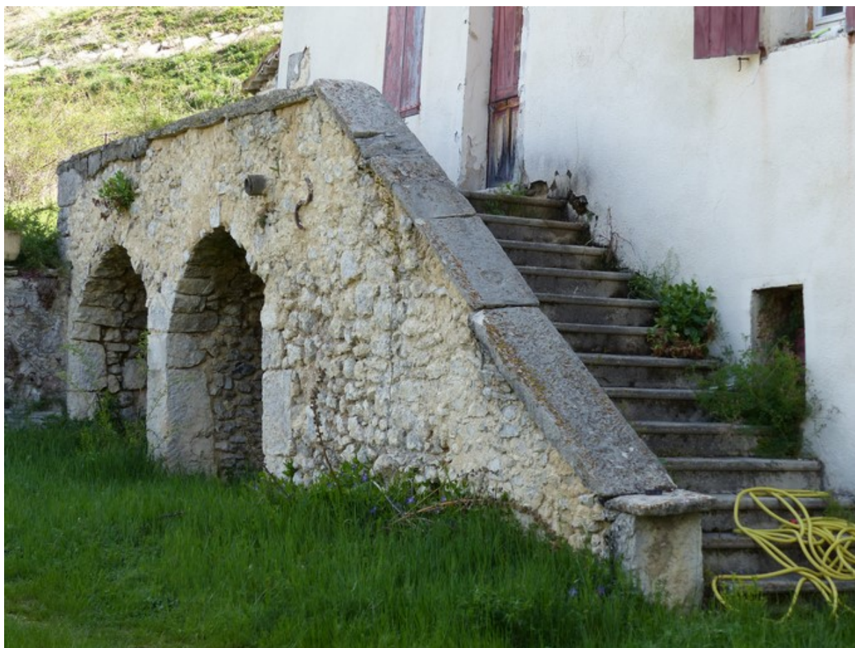
Bâtiment du logis. Elévation ouest, premier niveau. Escalier extérieur et palier filant sur deux voûtes en berceau.
