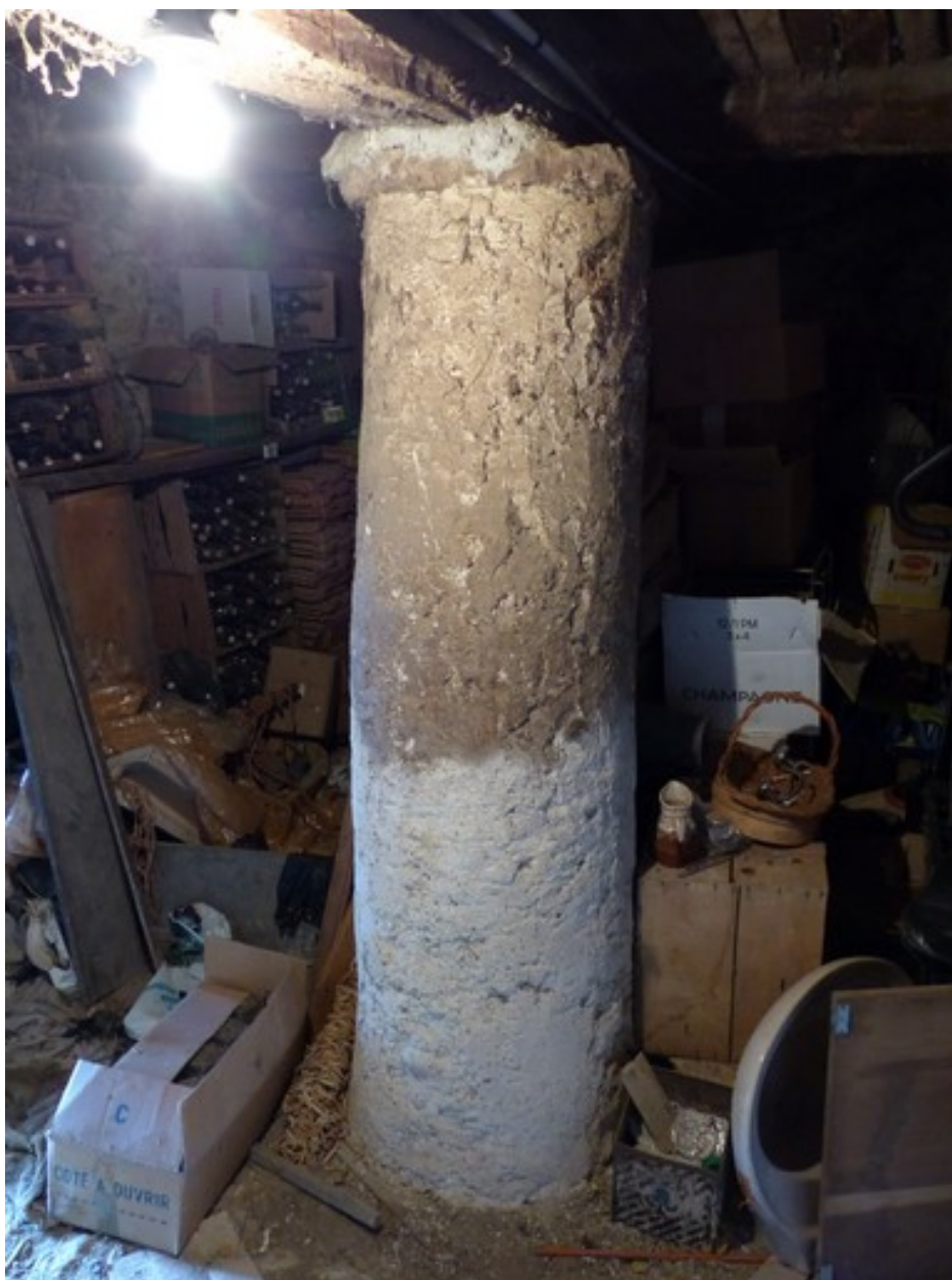
Bâtiment du logis. Etage de soubassement, cellier nord. Pilier circulaire maçonné.
