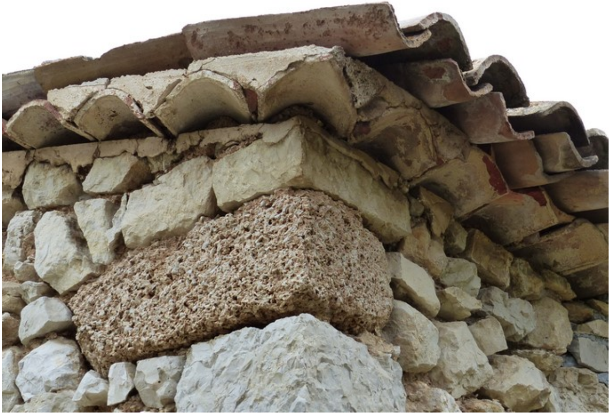
Bâtiment de la remise. Angle sud-ouest, passage du rang de génoise de l'avant-toit vers la saillie de rive.
