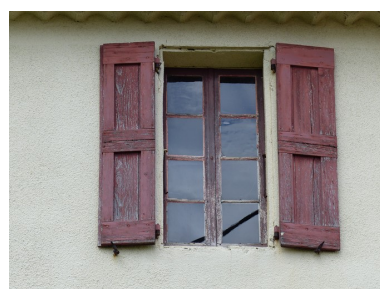
Bâtiment du logis. Elévation ouest, troisième niveau. Fenêtre équipée de contrevents à cadre. Phot. Alexeï Laurent IVR84_20162600561NUCA
