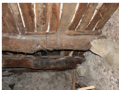
Bâtiment du logis. Etage de soubassement, cellier nord. Mur est, corbeaux maçonnés supportant les solives. Phot. Alexeï Laurent IVR84_20162600574NUCA
