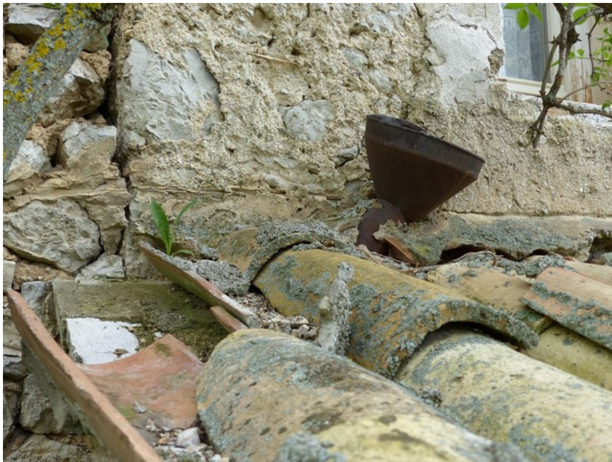
Bâtiment du logis. Pignon nord, ancien collecteur d'eau pluviale.
