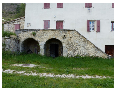
Bâtiment du logis. Elévation ouest, escalier extérieur et palier filant sur deux voûtes en berceau. Phot. Alexeï Laurent IVR84_20162600554NUCA
