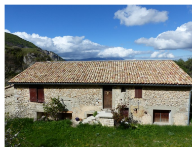
Bâtiment du logis. Elévation est. Phot. Alexeï Laurent IVR84_20162600567NUCA
