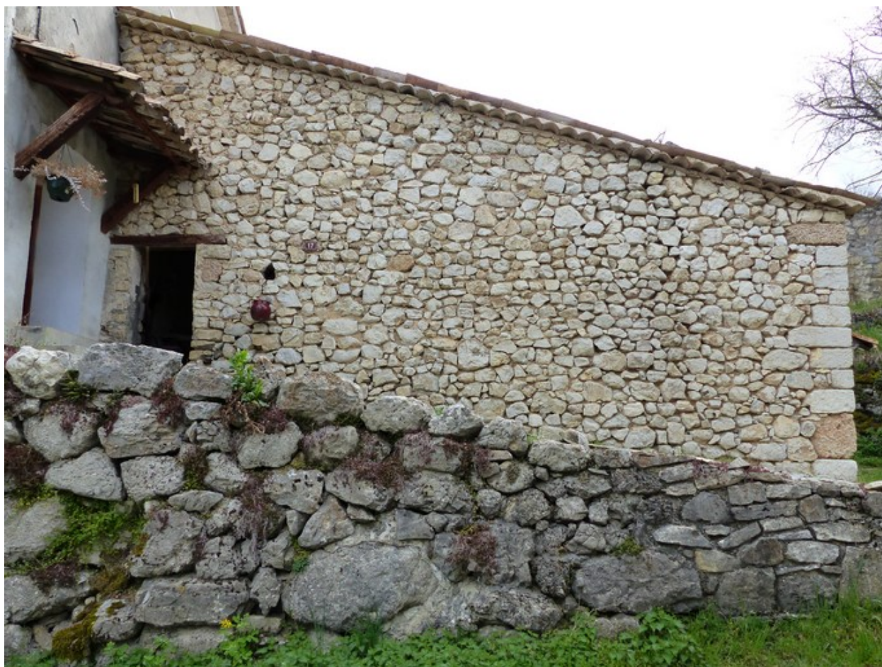
Bâtiment de la remise. Pignon ouest.
