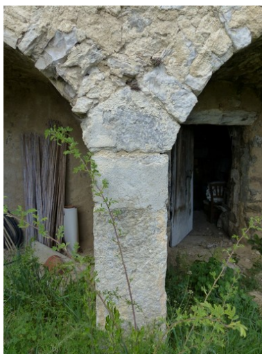
Bâtiment du logis. Elévation ouest, jambage en pierre de taille, commun aux deux voûtes du palier filant extérieur. Phot. Alexeï Laurent IVR84_20162600557NUCA
