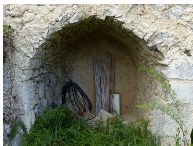
Bâtiment du logis. Elévation ouest, voûte nord du palier filant extérieur. Vue de volume. Phot. Alexeï Laurent IVR84_20162600556NUCA
