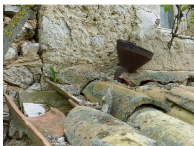
Bâtiment du logis. Pignon nord, ancien collecteur d'eau pluviale. Phot. Alexeï Laurent IVR84_20162600565NUCA
