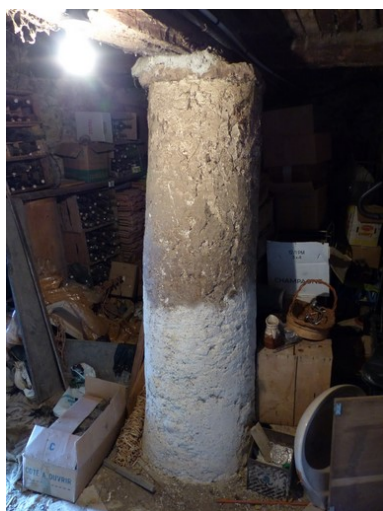
Bâtiment du logis. Etage de soubassement, cellier nord. Pilier circulaire maçonné. Phot. Alexeï Laurent IVR84_20162600571NUCA
