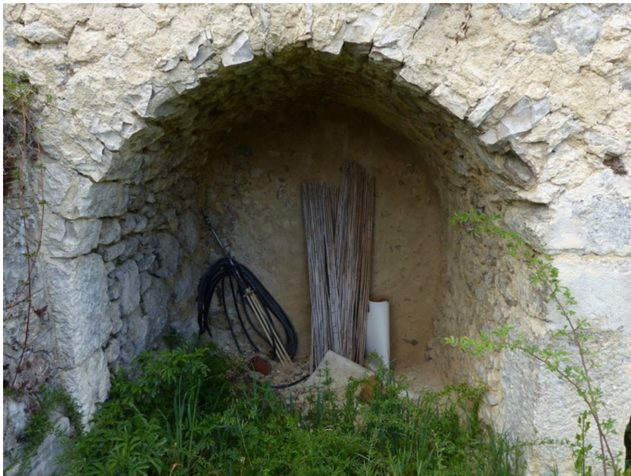
Bâtiment du logis. Elévation ouest, voûte nord du palier filant extérieur. Vue de volume.
