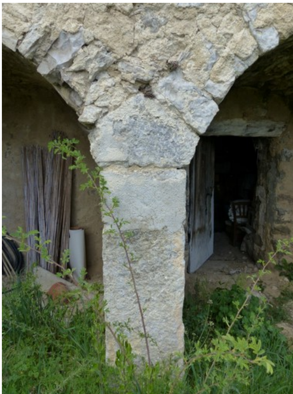
Bâtiment du logis. Elévation ouest, jambage en pierre de taille, commun aux deux voûte du palier filant extérieur.
