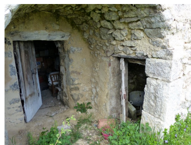
Bâtiment du logis. Elévation ouest, voûte sud du palier filant extérieur et étable à cochon aménagée sous le rampant de l'escalier. Phot. Alexeï Laurent IVR84_20162600558NUCA
