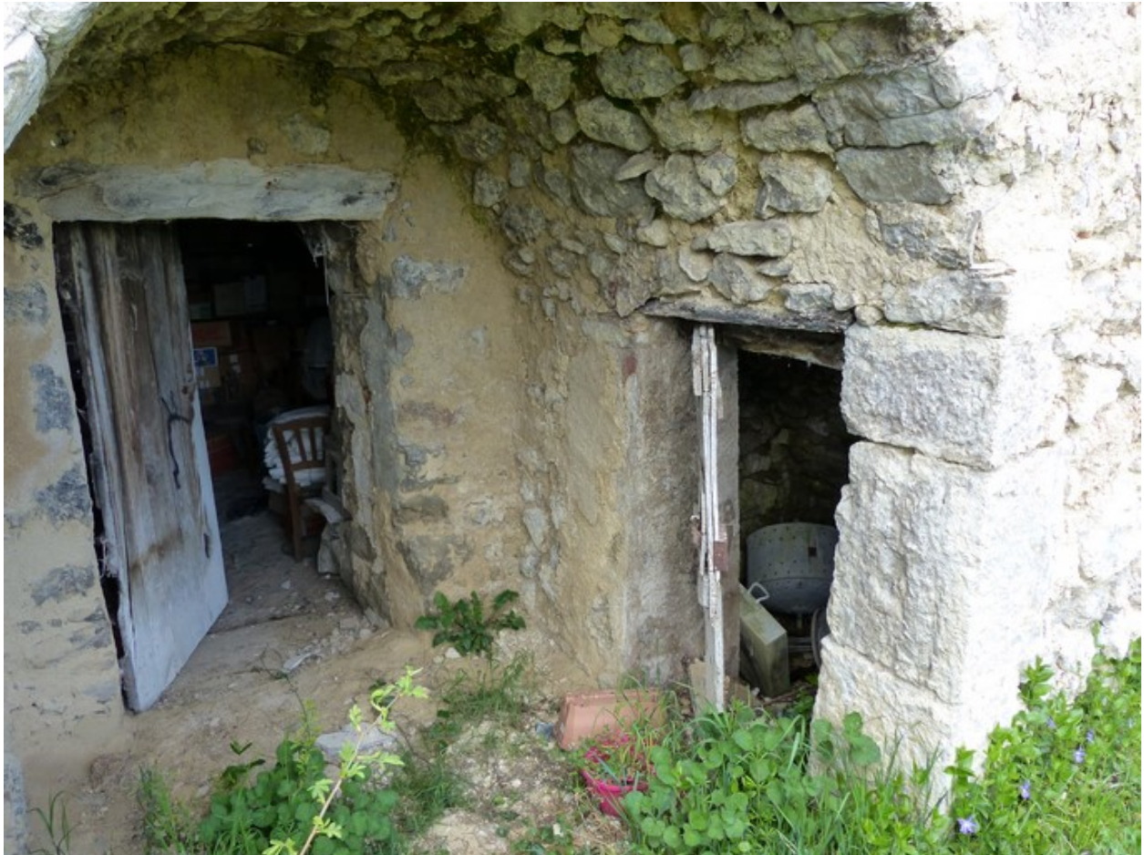
Bâtiment du logis. Elévation ouest, voûte sud du palier filant extérieur et étable à cochon aménagée sous le rampant de l'escalier.
