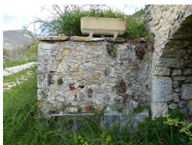
Bâtiment du réservoir. Elévation sud, et arrachement du lavoir en béton. Phot. Alexeï Laurent IVR84_20162600562NUCA
