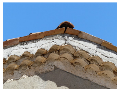
Bâtiment du logis. Pignon sud, saillie de rive constituée de deux rangs de génoise peints en blanc, décor peint de cadre de façade. Phot. Alexeï Laurent IVR84_20162600570NUCA
