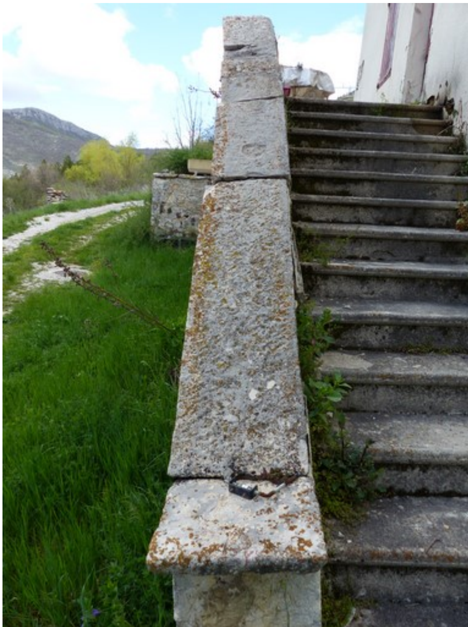
Bâtiment du logis. Escalier extérieur, main courante en pierre de taille.
