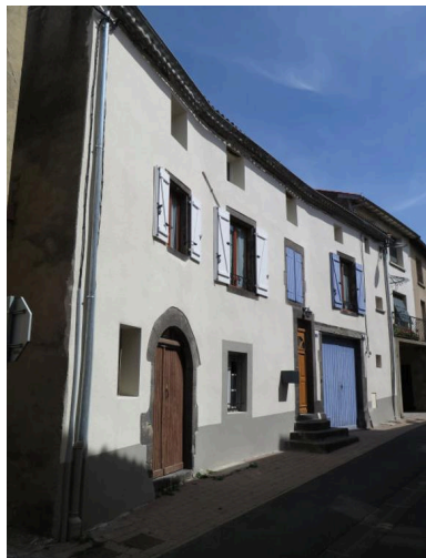
Vue générale Phot. Bruno Decrock IVR84_20206300037NUCA
