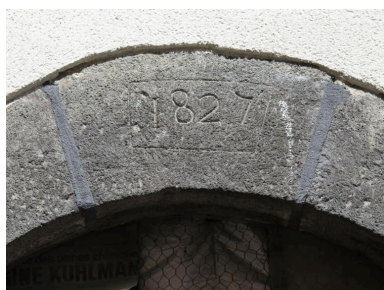
Date gravée sur la clef d'arc d'entrée de la cave : 1827 Phot. Bruno Decrock IVR84_20206300038NUCA
