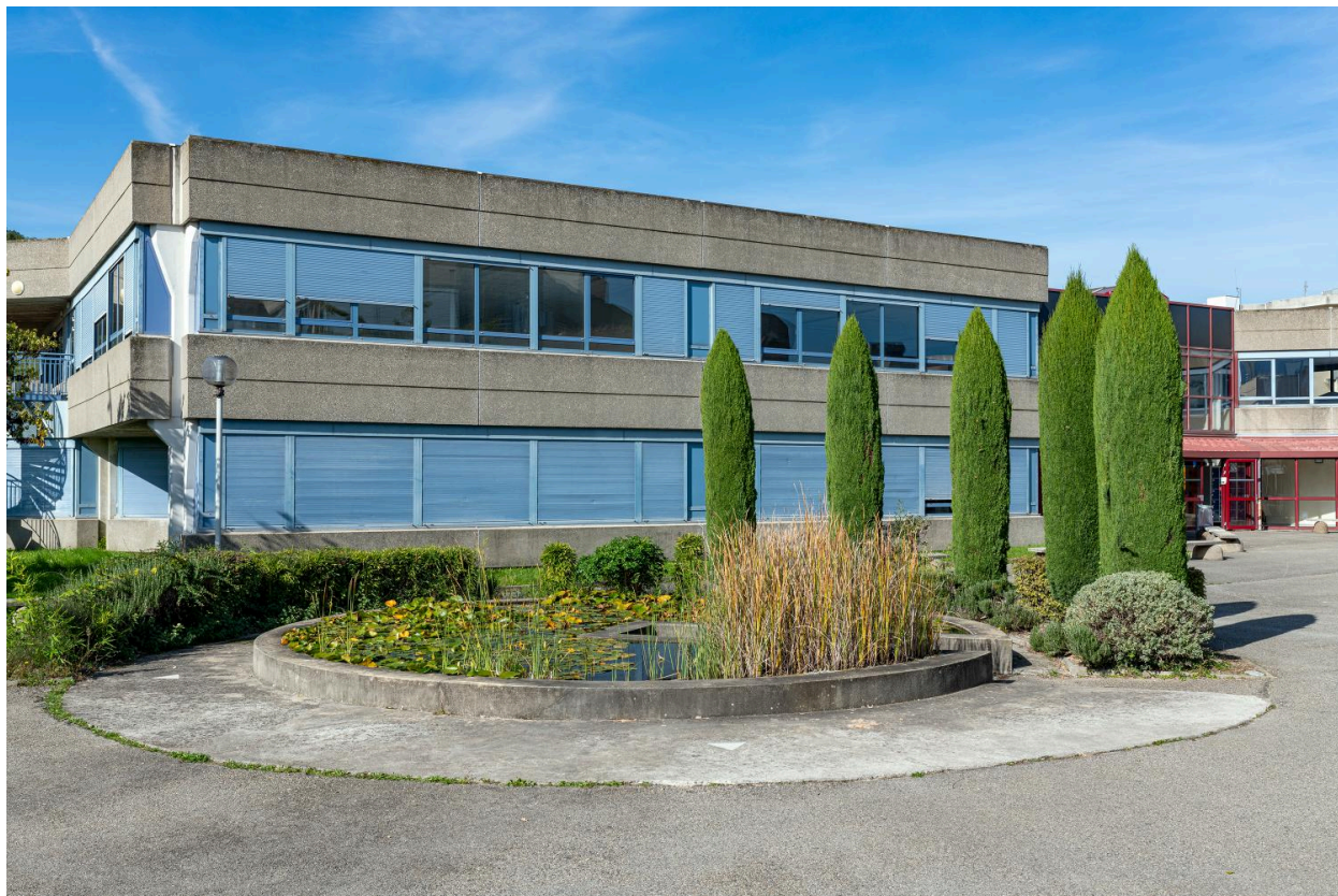
Installation extérieure : vue d'ensemble en 2020
