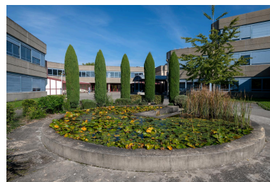
Installation extérieure : vue rapprochée en 2020 Phot. Michel Pérès IVR84_20200700081NUCA
