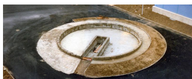
L'installation en cours de réalisation, vue n°2 (phot. M. Papapietro) Repro. Catherine Guégan, Phot. Mathilde Papapietro IVR84_20220700191NUCA
