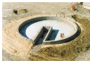
L'installation extérieure en cours de réalisation, vue n °1 (phot. M. Papapietro) Repro. Catherine Guégan, Phot. Mathilde Papapietro IVR84_20220700192NUCA
