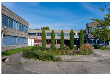
Installation extérieure : autre vue d'ensemble en 2020 Phot. Michel Pérès IVR84_20200700080NUCA
