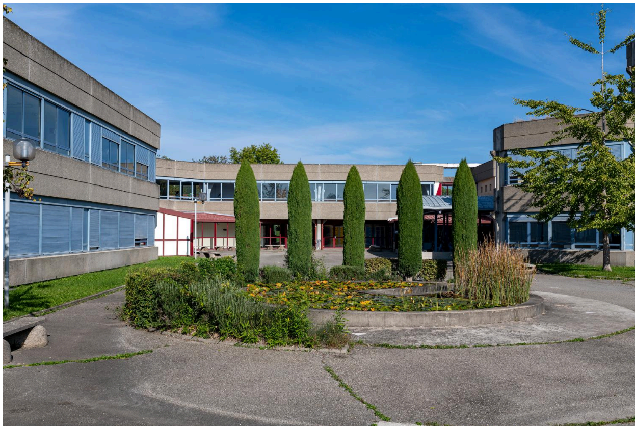
Installation extérieure : autre vue d'ensemble en 2020
