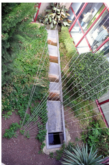
Installation intérieure, vue depuis le haut Phot. Catherine Guégan IVR84_20220700237NUCA
