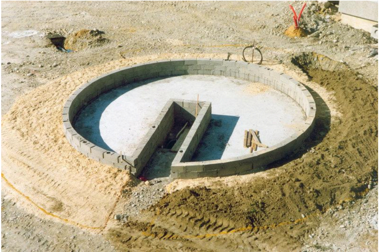
L'installation extérieure en cours de réalisation, vue n°1 (phot. M. Papapietro)
