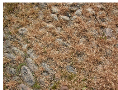
Détail du sol de la cour : pavage de galets. Phot. Thierry Monnet IVR82_20134204280NUCA
