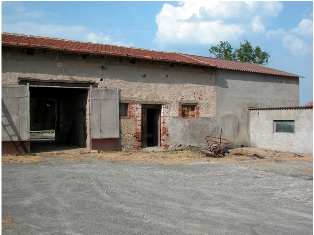
Vue de la grange-étable nord.
