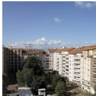
Elévation postérieure et cœur d'îlot vus depuis le toit du Musée des missions africaines Phot. Eric Dessert IVR82_20056901604NUCA
