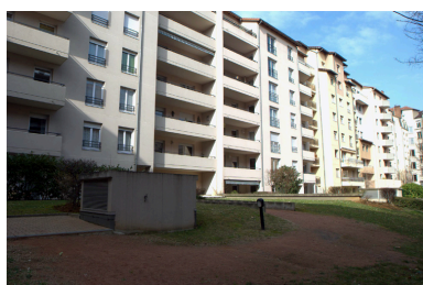
Elévation postérieure, vue partielle Phot. Maryannick Chalabi IVR82_20126902451NUCA
