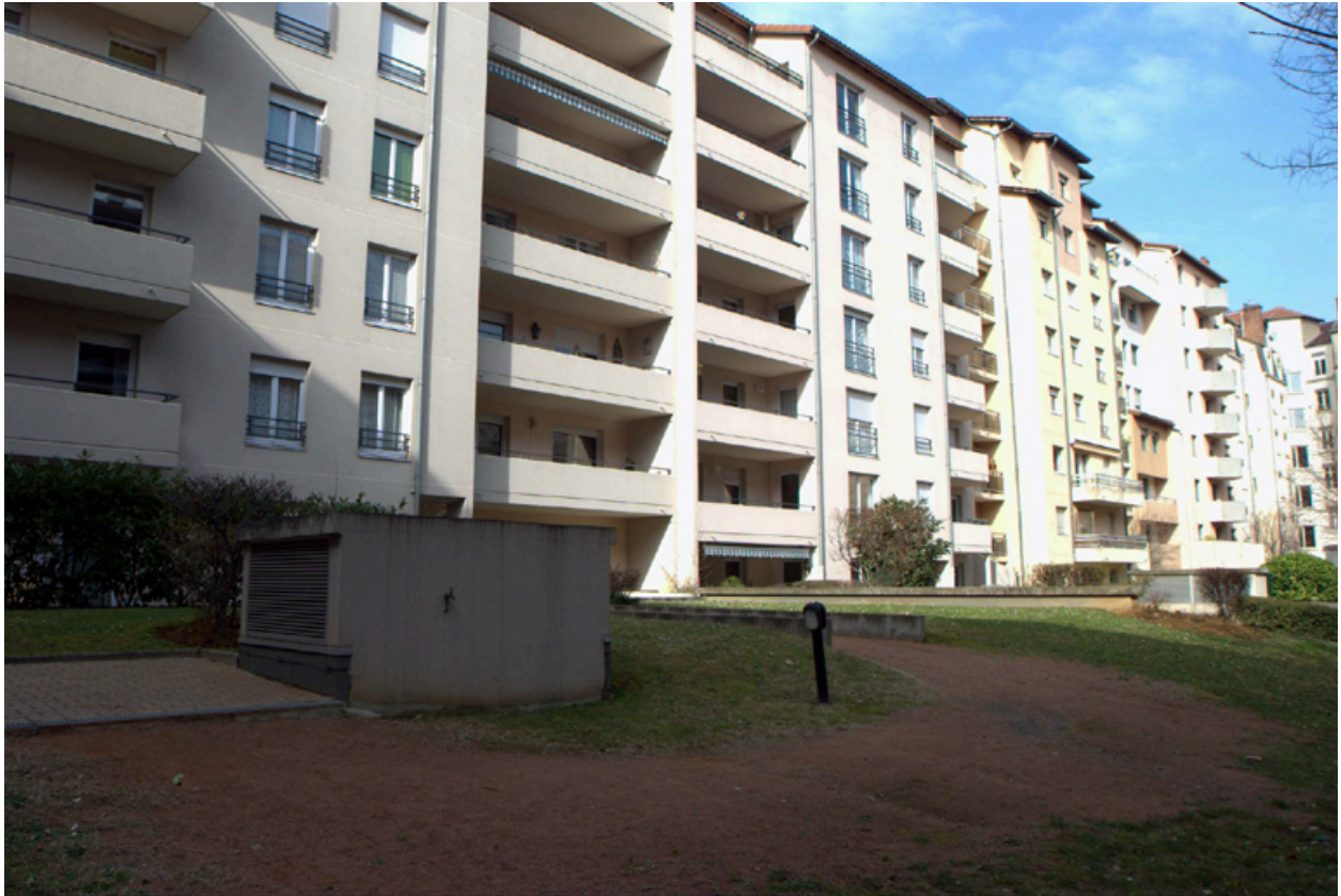
Elévation postérieure, vue partielle
