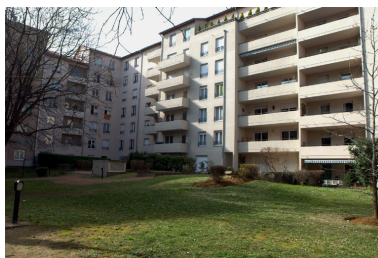
Elévation postérieure, depuis le nord-est Phot. Maryannick Chalabi IVR82_20126902453NUCA
