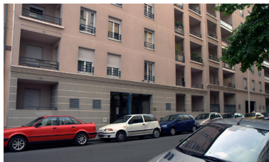
Elévation rue Nicolaï, vue partielle Phot. Maryannick Chalabi IVR82_20126903059NUCA
