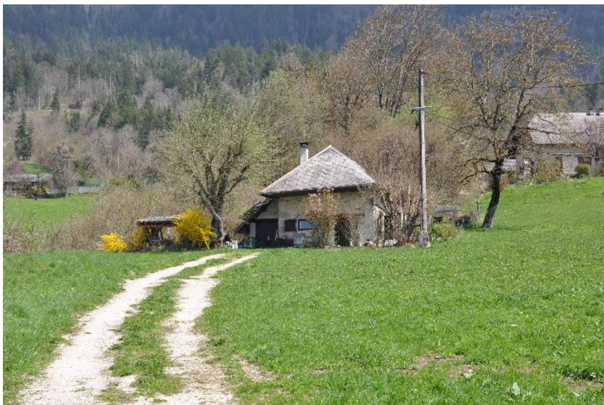
Vue du moulin amont.
