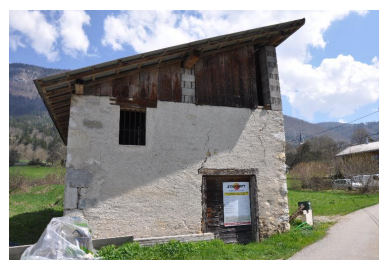
Vue du moulin aval. Phot. Clara Bérelle IVR82_20137301759NUCA
