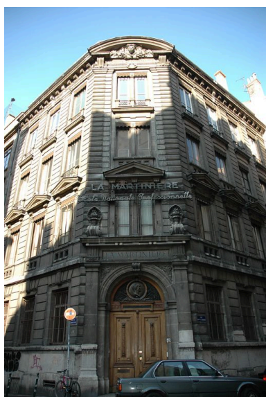
Elévations sur la rue Hippolyte- Flandrin et la rue des Augustins Phot. Véronique Belle IVR82_20066901118NUCA
