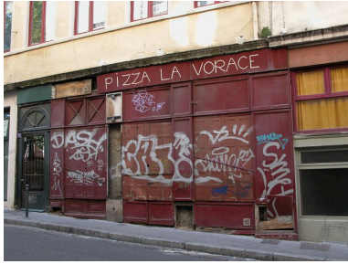
Façade sur rue, boutique de droite Phot. Bernard Ducouret IVR82_20046901559NUCA
