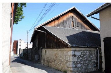
Vue d'ensemble depuis le sud Phot. Denys Harreau IVR82_20137300734NUCA
