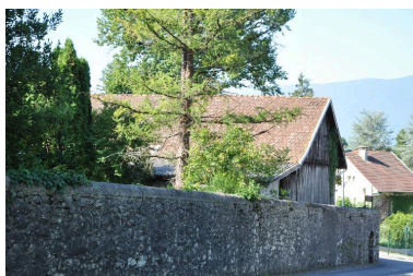
Vue d'ensemble depuis l'est Phot. Denys Harreau IVR82_20137300729NUCA
