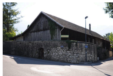
Vue d'ensemble depuis l'ouest Phot. Denys Harreau IVR82_20137300733NUCA
