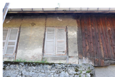
Détail de la partie supérieure de l'élévation sud Phot. Denys Harreau IVR82_20137300728NUCA
