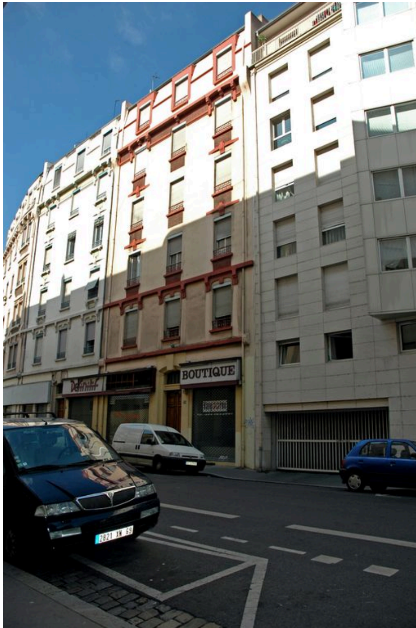
Vue d'ensemble des 270-272 depuis le nord-est
