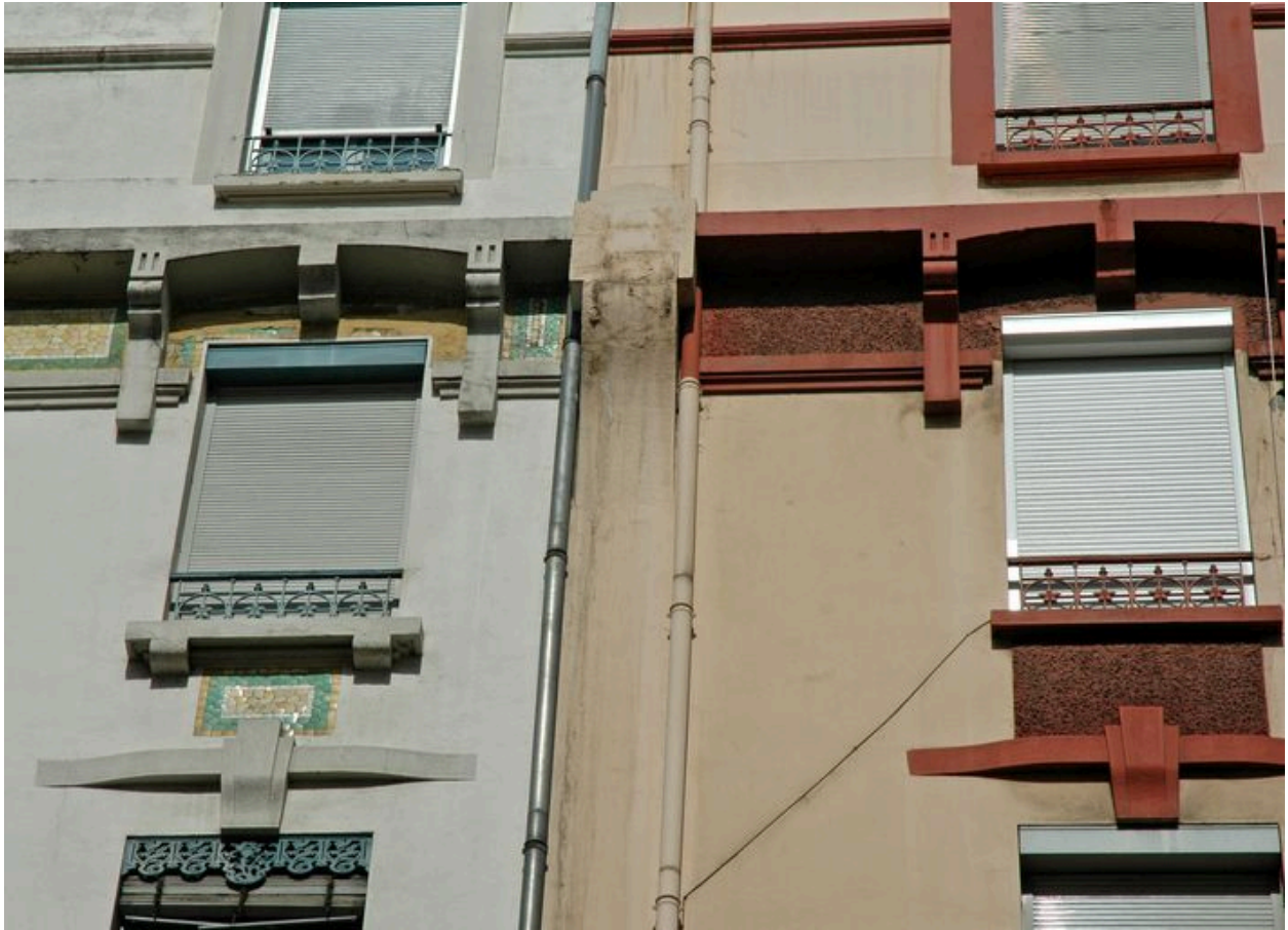
270-272 rue de Créqui. Détail des fenêtres
