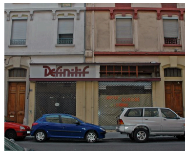
Rez-de-chaussée sur rue des 270-272 Phot. Maryannick Chalabi IVR82_20076900311NUCA
