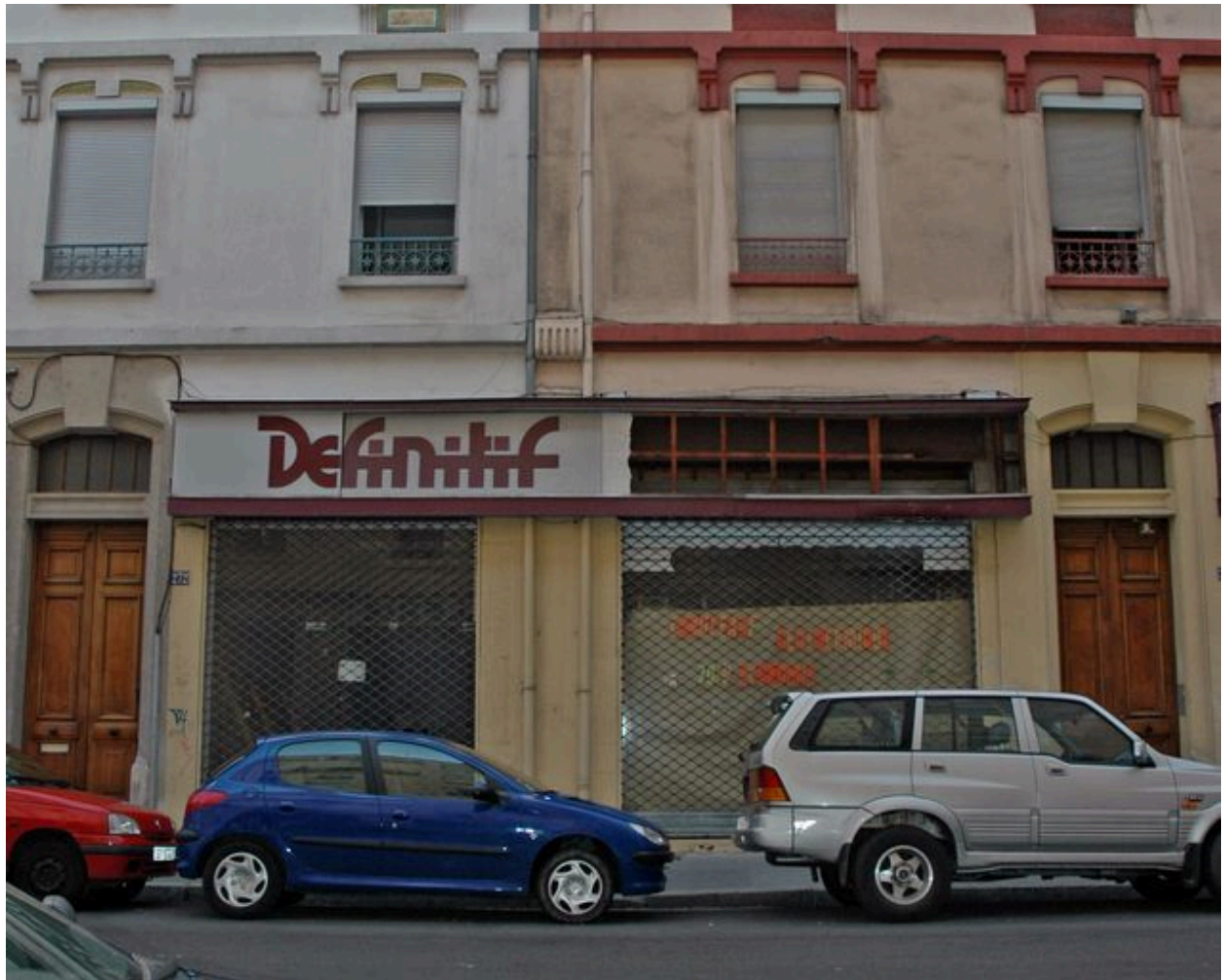
Rez-de-chaussée sur rue des 270-272
