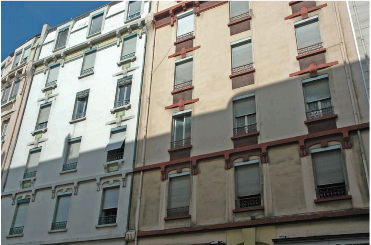
270-272 rue de Créqui. Détail de l'élévation principale
