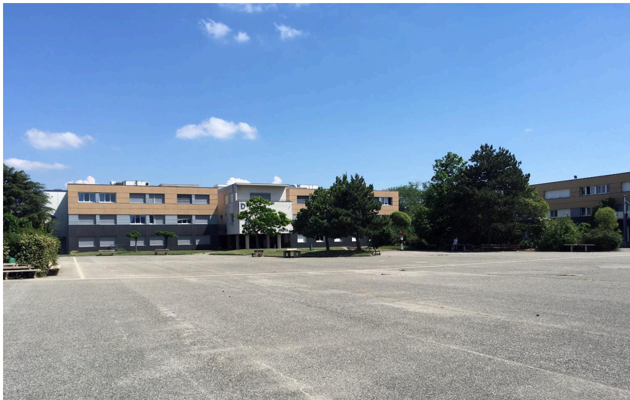
Le bâtiment D après restructuration et la cour principale
