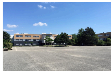
Le bâtiment D après restructuration et la cour principale Phot. Catherine Guégan IVR84_20212600041NUCA
