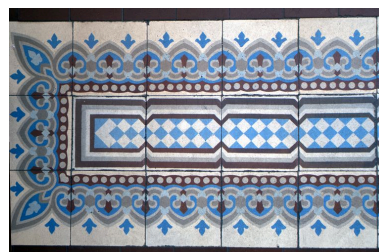
Carrelage en carreaux de ciment, détail de la frise Phot. Maryannick Chalabi IVR82_20116904042NUCA
