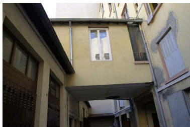
Vue de la conciergerie construite en encorbellement au-dessus de la cour Phot. David Chevallier IVR82_20046904695NUCA
