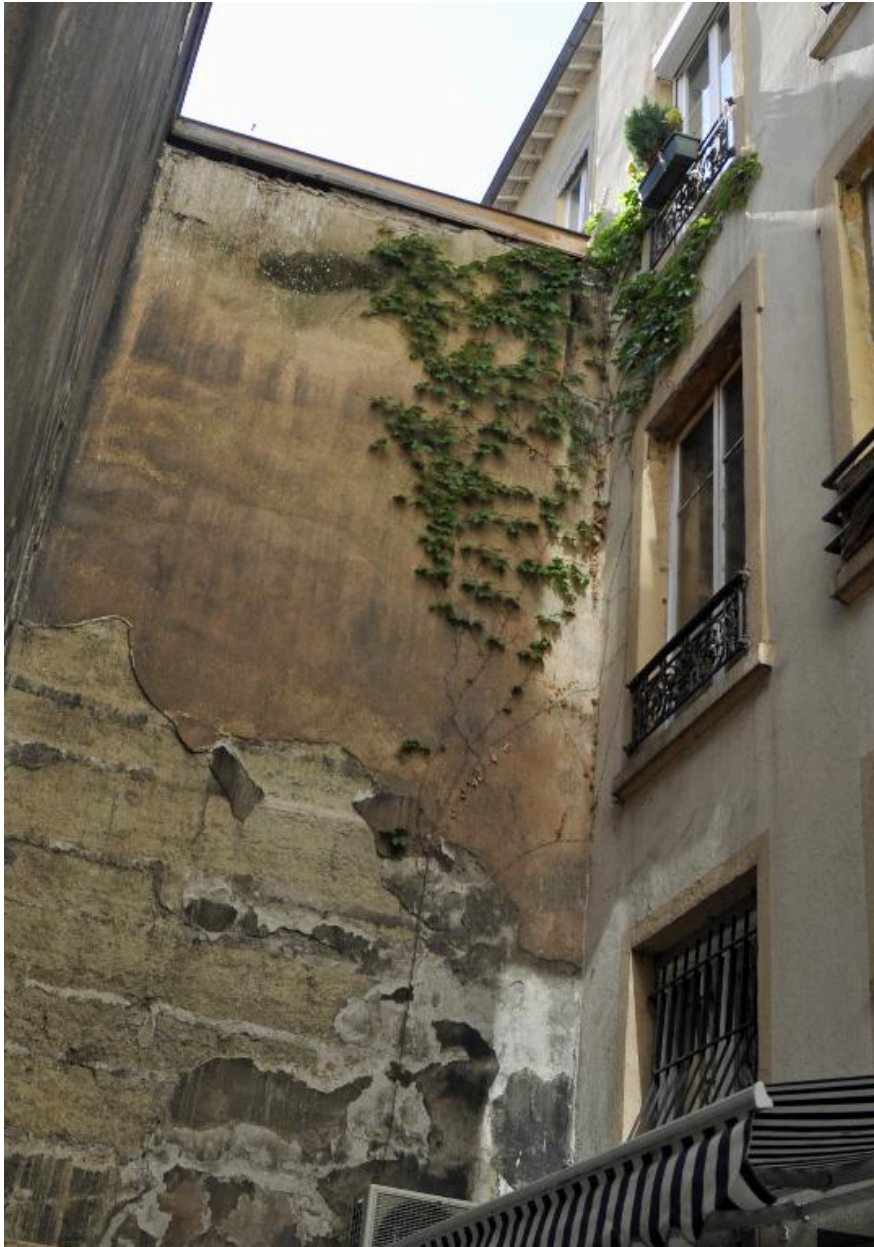
Mur sud-ouest du bâtiment sur cour, en pisé enduit (vue depuis la cour du 3 rue d'Aguesseau)
