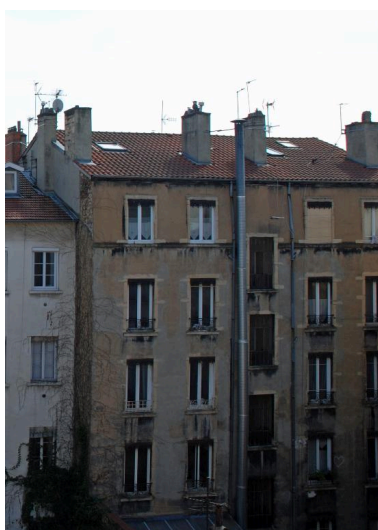
Vue générale de l'élévation sur cour Phot. Catherine Guégan IVR82_20156900984NUCA
