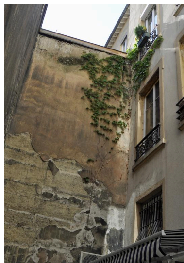
Mur sud-ouest du bâtiment sur cour, en pisé enduit (vue depuis la cour du 3 rue d'Aguesseau) Phot. Catherine Guégan IVR82_20156900968NUCA
