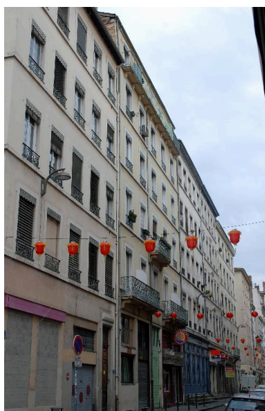
Vue générale de l'élévation sur rue Phot. Catherine Guégan IVR82_20156900988NUCA
