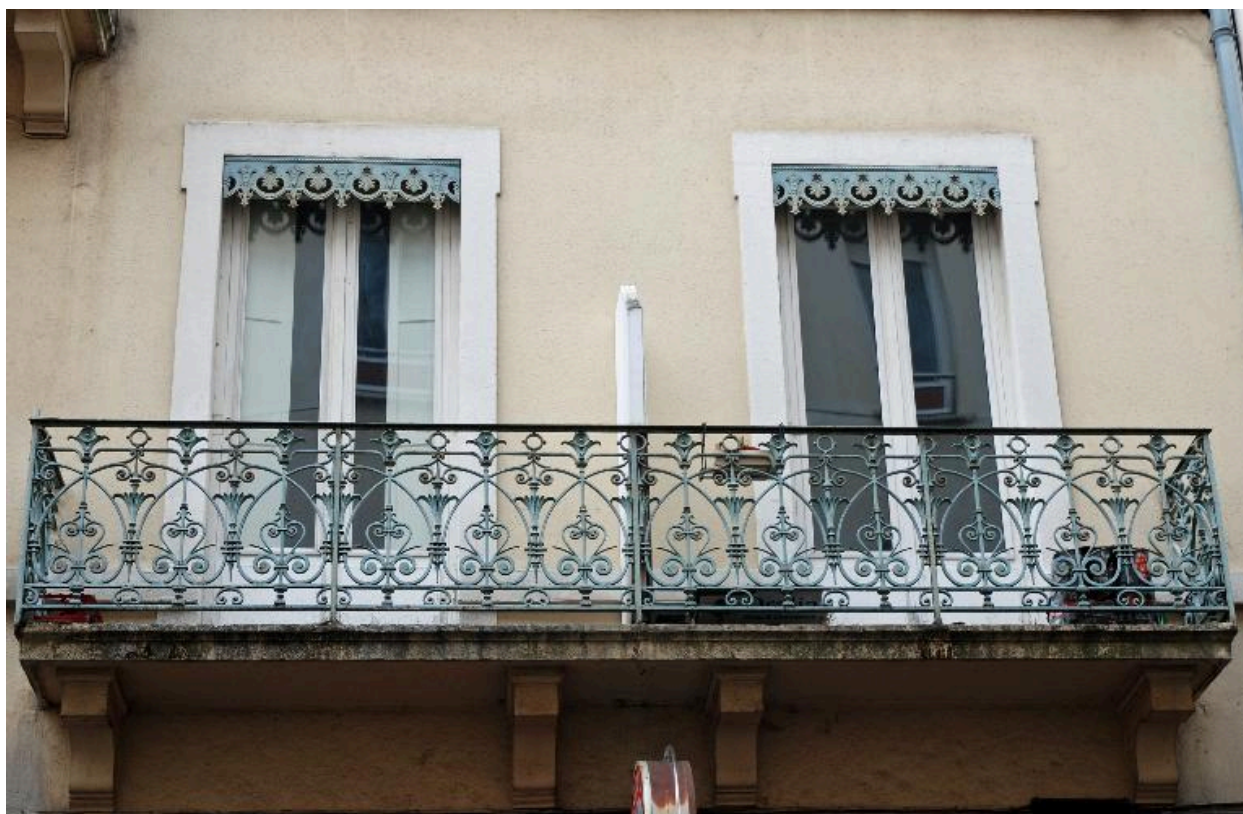
Vue rapprochée d'un des balcons du premier étage
