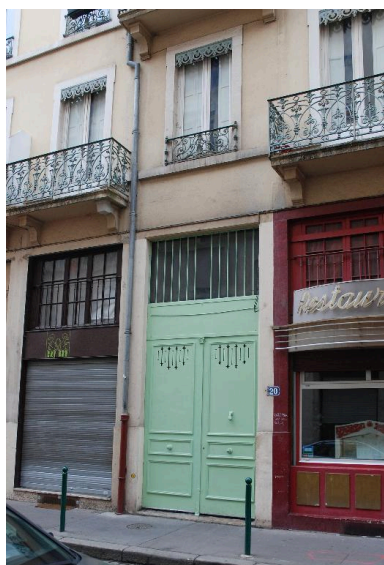
Vue rapprochée de la porte Phot. Catherine Guégan IVR82_20156900989NUCA
