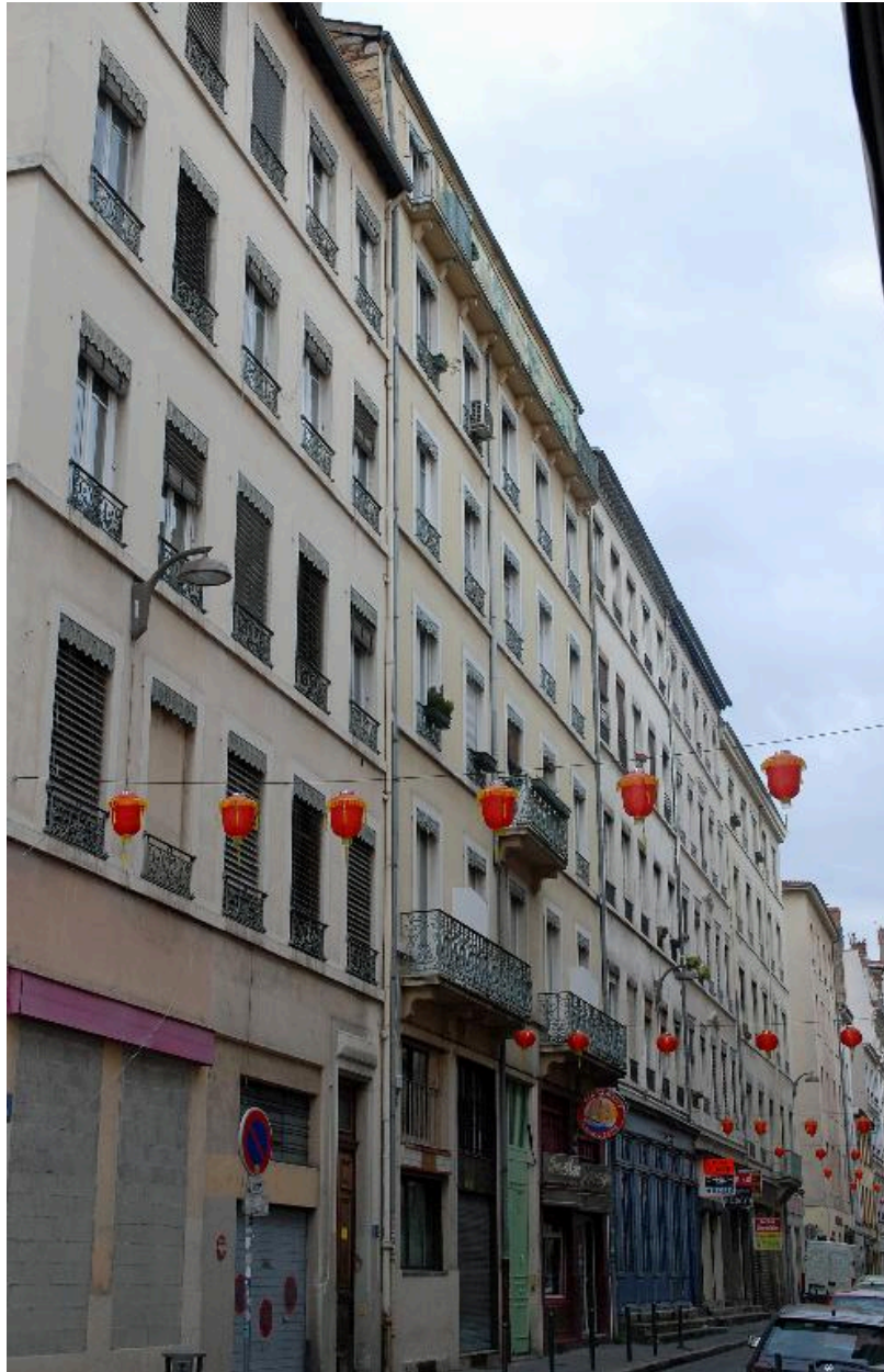
Vue générale de l'élévation sur rue
