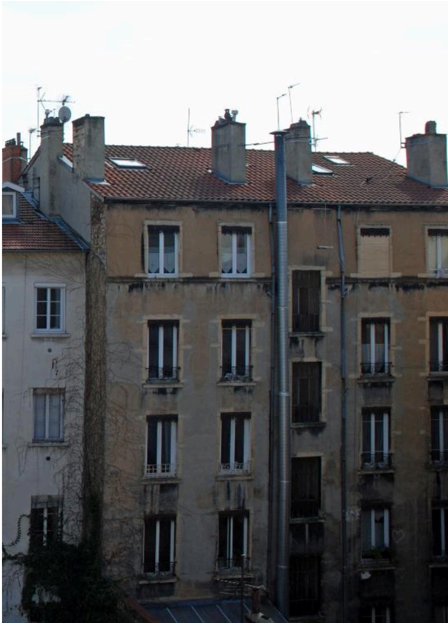
Vue générale de l'élévation sur cour
