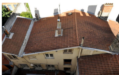
Corps de bâtiment ouest, vue latérale Phot. Magali Delavenne IVR82_20156901261NUCA
