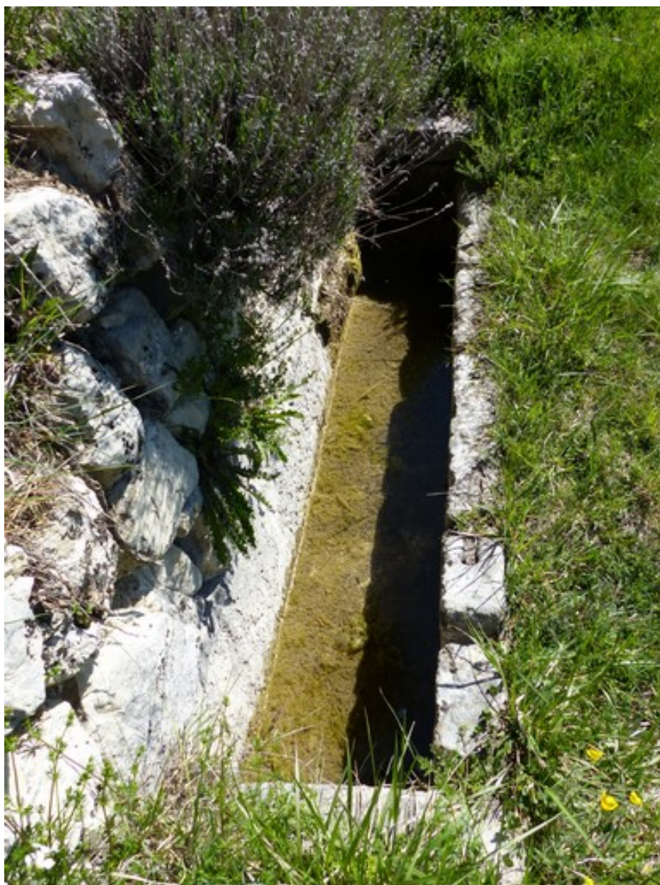
Bassin, vue d'ensemble.
