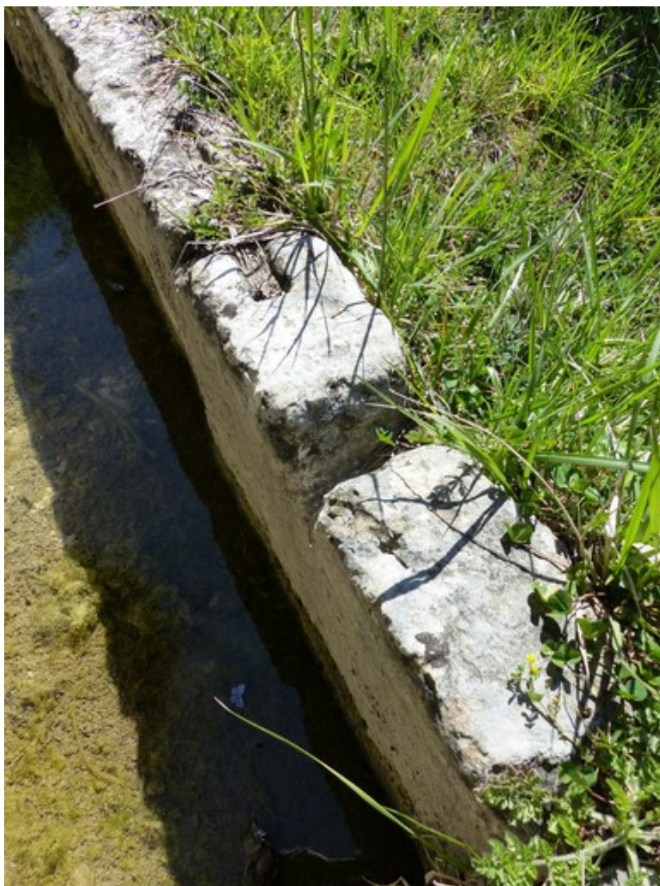
Bassin, détail de la margelle.
