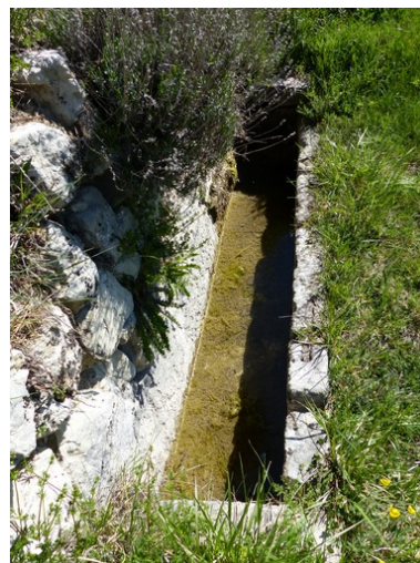
Bassin, vue d'ensemble. Phot. Alexeï Laurent IVR84_20162600246NUCA
