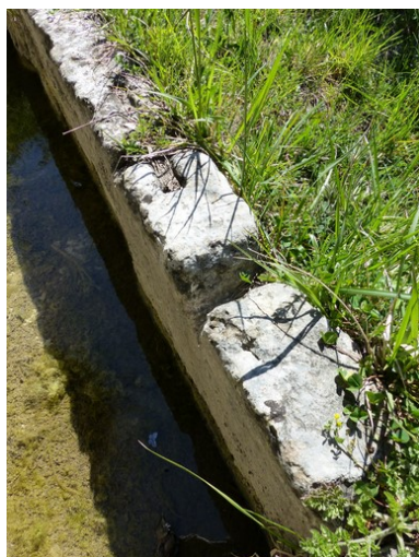
Bassin, détail de la margelle. Phot. Alexeï Laurent IVR84_20162600247NUCA
