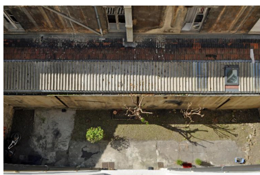
Vue plongeante sur la cour et les remises Phot. Catherine Guégan IVR82_20156901127NUCA
