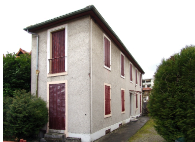
Vue générale avant travaux Phot. François Fouger IVR82_20087300206NUCA
