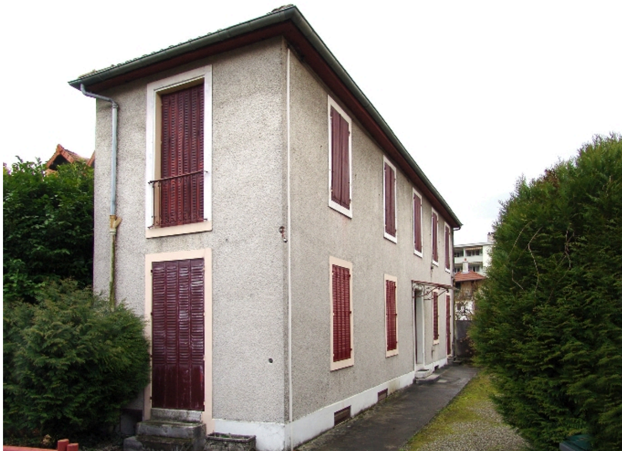
Vue générale avant travaux
