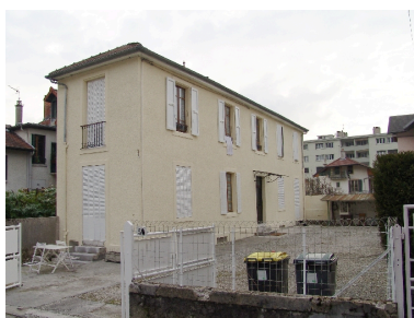
Vue générale après travaux Phot. François Fouger IVR82_20097300118NUCA
