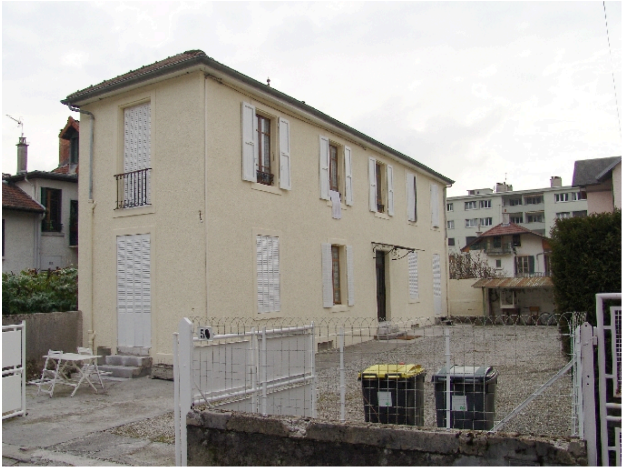
Vue générale après travaux
