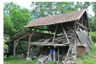
Grange au sud du moulin Phot. Yannick Milleret IVR82_20107300855NUCA
