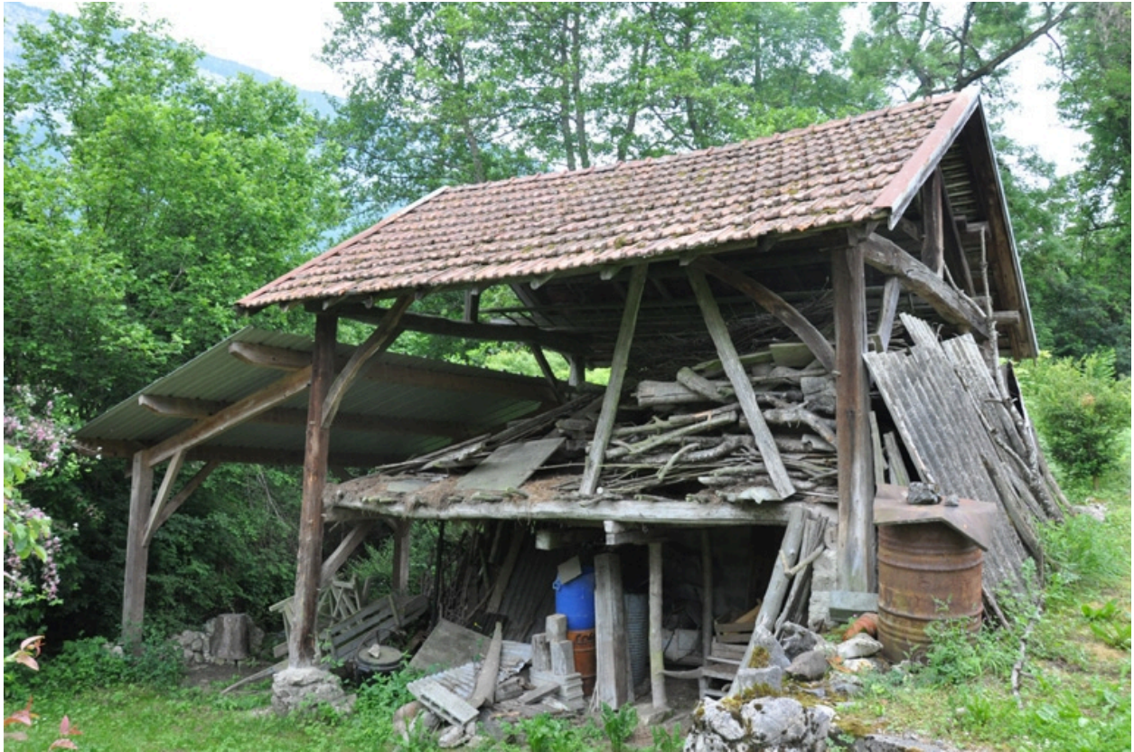
Grange au sud du moulin
