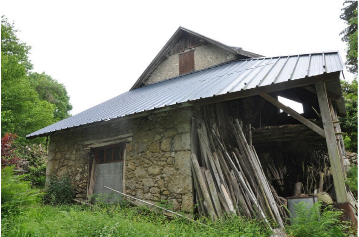
Vue de la ouest avec l'espace consacré au moulin au premier plan
