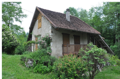
Vue générale du moulin (façades sud et ouest) transformé en gîte Phot. Yannick Milleret IVR82_20107300804NUCA
