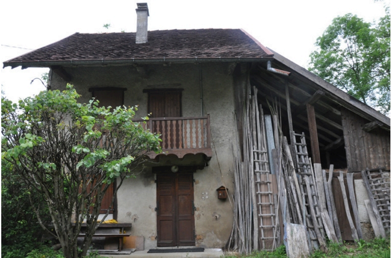
Vue de la façade sud
