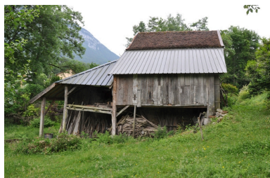
Vue de la façade nord Phot. Yannick Milleret IVR82_20107300853NUCA
