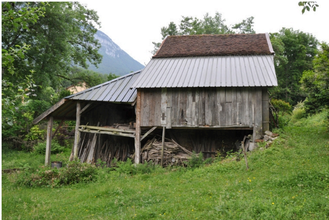
Vue de la façade nord
