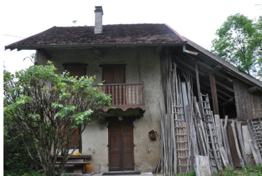
Vue de la façade sud Phot. Yannick Milleret IVR82_20107300851NUCA
