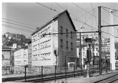
Vue générale depuis le sud-ouest Phot. Jean-Marie Refflé IVR82_20026903552P
