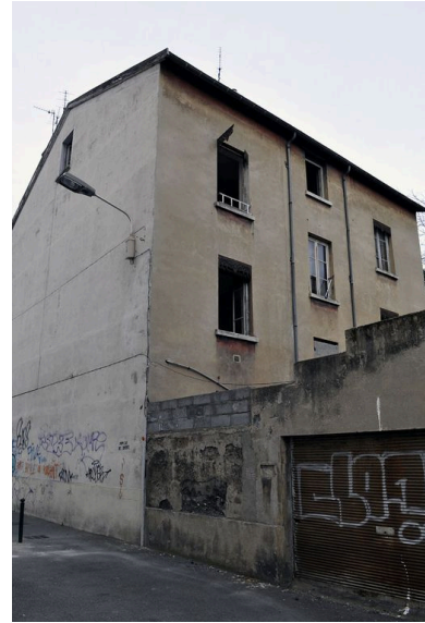
Façade postérieure Phot. Julien Defillon IVR82_20106900993NUCA
