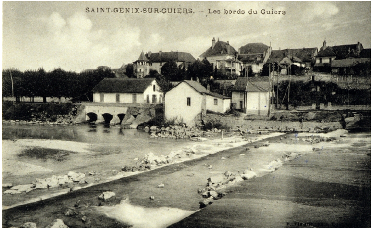
Centrale hydroélectrique, début du 20e siècle
