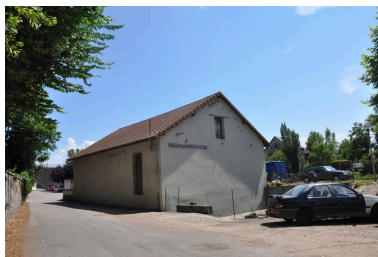
Vue de la centrale, façades nord et ouest Phot. Yannick Milleret IVR82_20107300541NUCA
