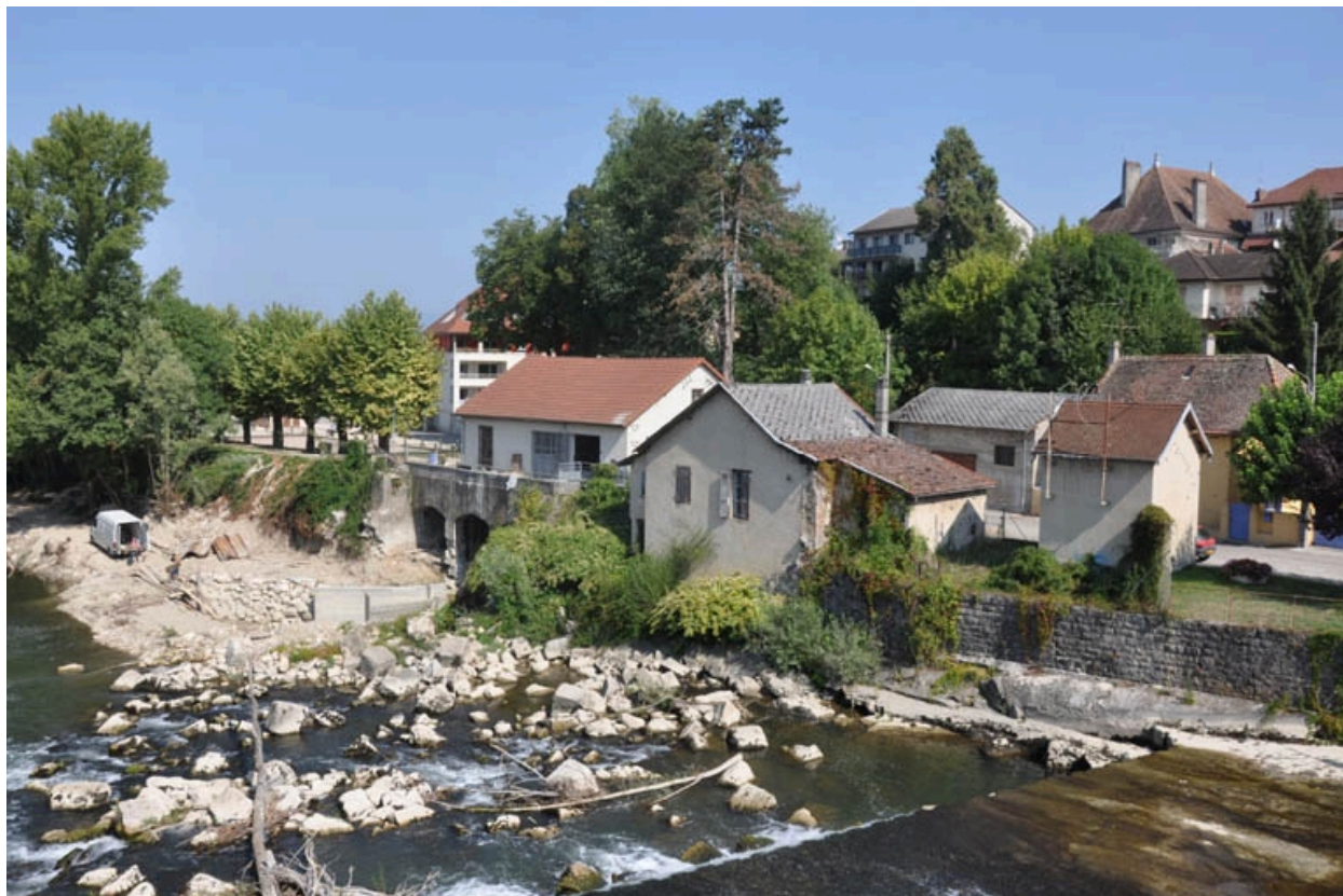
Vue générale de la centrale hydroélectrique, du logement et du transformateur, façade sud-ouest
