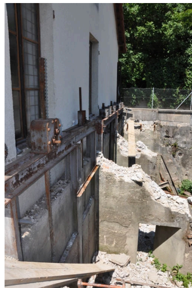
Vue de la façade est de la centrale avec le système de vannage Phot. Yannick Milleret IVR82_20107300543NUCA
