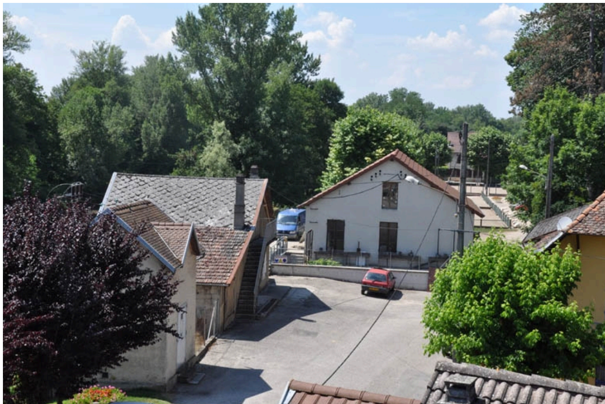
Vue de la centrale, façade est
