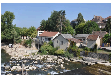
Vue générale de la centrale hydroélectrique, du logement et du transformateur, façade sud-ouest Phot. Yannick Milleret IVR82_20107300539NUCA
