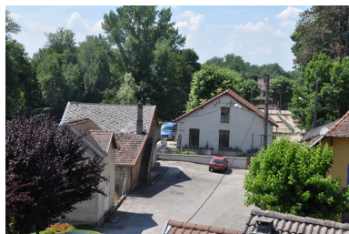
Vue de la centrale, façade est Phot. Yannick Milleret IVR82_20107300540NUCA
