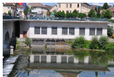
Vue de la prise d'eau avec trois vannes le long de la rivière du Guiers Phot. Yannick Milleret IVR82_20107300542NUCA
