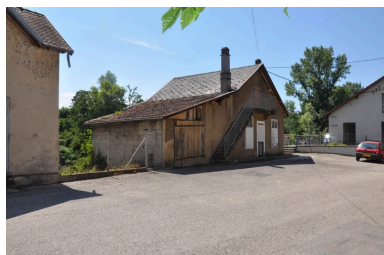
Vue du logement du gardien, façade nord Phot. Yannick Milleret IVR82_20107300544NUCA
