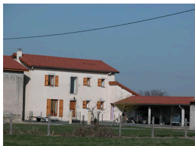
Vue d'ensemble partielle de la ferme. Phot. Thierry Monnet IVR82_20144200183NUCA
