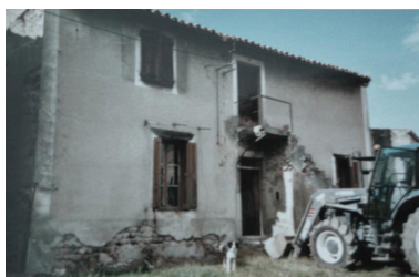
Photo ancienne de la façade avant Phot. Thierry Monnet IVR82_20144200181NUCA
