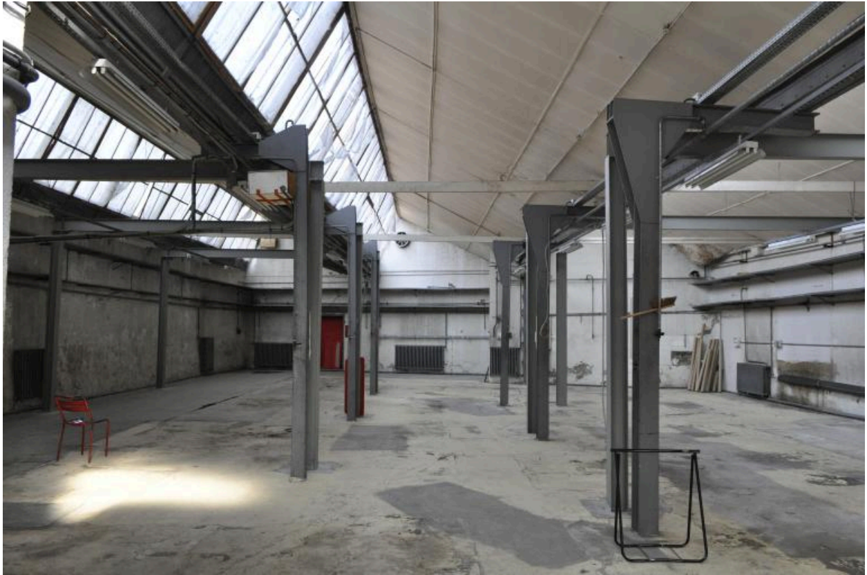
Vue intérieur des ateliers.
