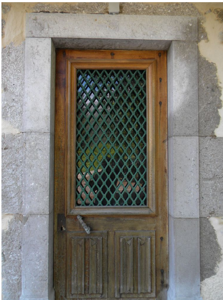
Encadrement de porte sur la façade nord.
