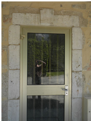
Encadrement de porte sur le pignon ouest. Phot. Jérôme Daviet IVR82_20117403624NUCA
