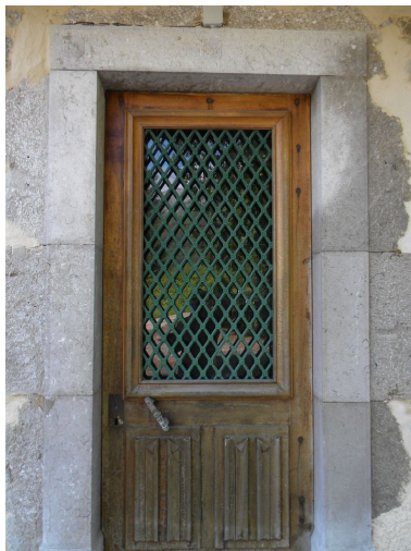
Encadrement de porte sur la façade nord. Phot. Jérôme Daviet IVR82_20117403619NUCA
