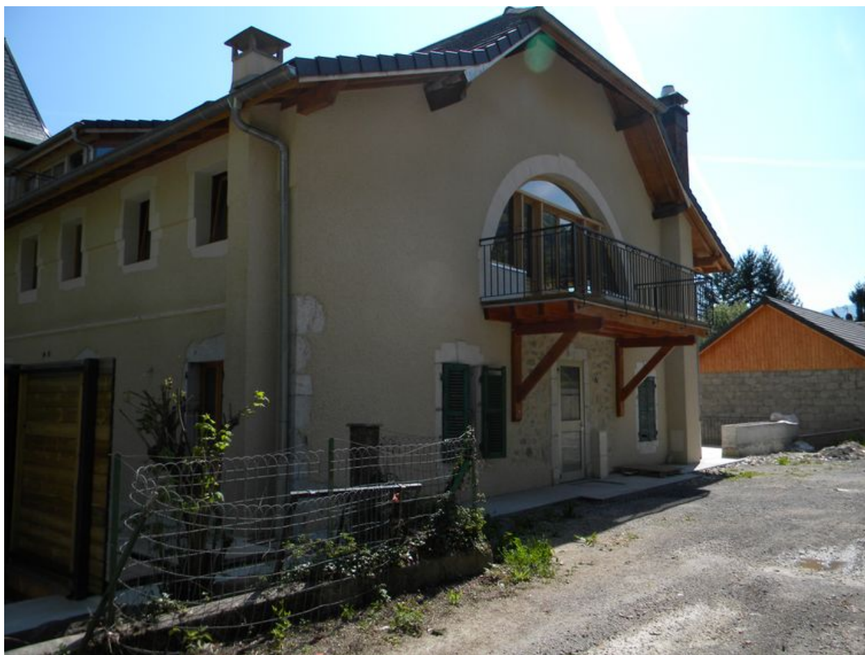
Vue du pignon ouest.
