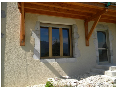
Fenêtre agrandie avec d'anciennes pierres de taille. Phot. Jérôme Daviet IVR82_20117403621NUCA
