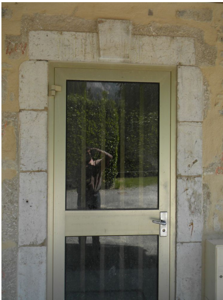
Encadrement de porte sur le pignon ouest.
