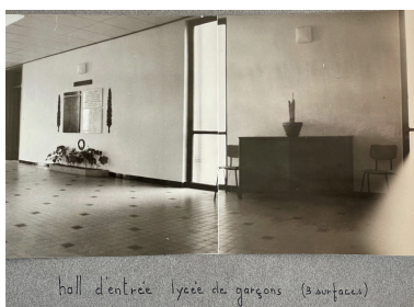
Le hall d'entrée des garçons avant la réalisation du 1% artistique (AN, 19880466/74) ; les éléments du monument aux morts fixés sur le mur ont été déplacés à l'extérieur du lycée, fixés sur les quatre côtés d'un socle en pierre, à proximité de la sculpture de P. Kaepelin. Repro. Catherine Guégan, Autr. Michèle Bargoin IVR84_20244300001NUC
