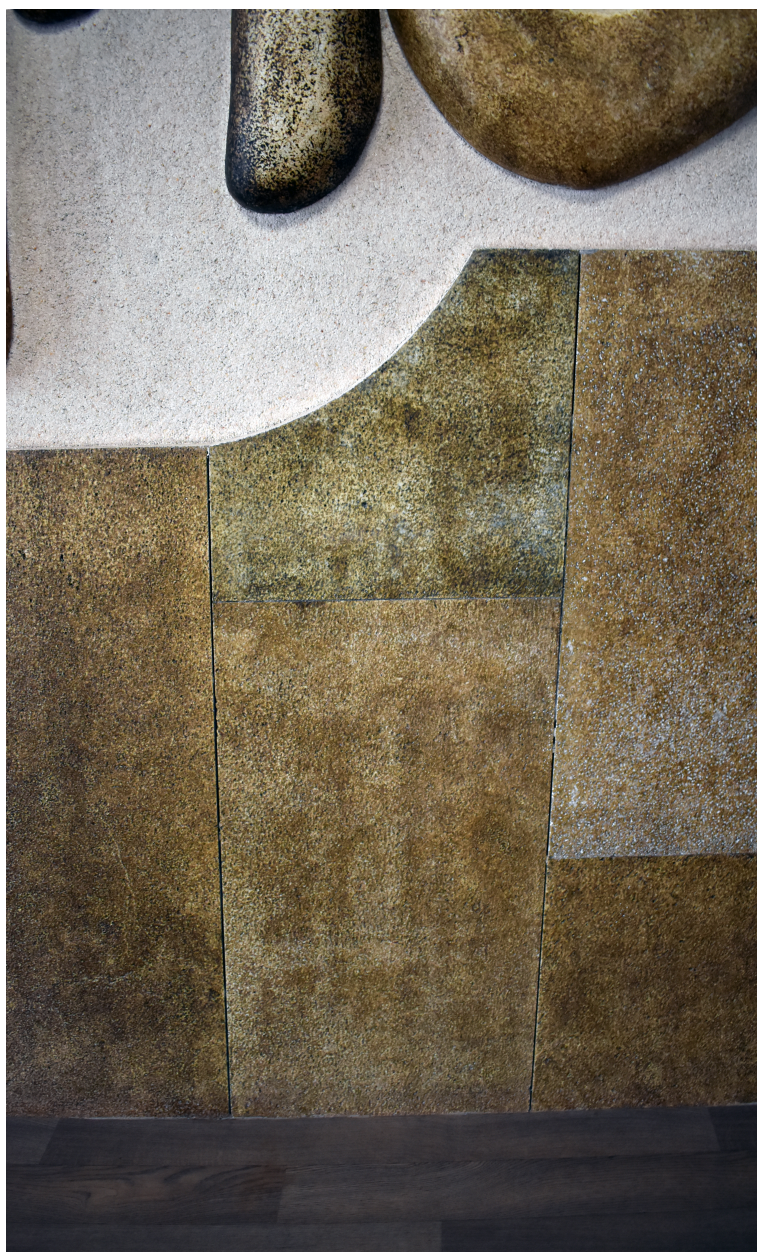
Détail des panneaux de revêtement en partie basse
