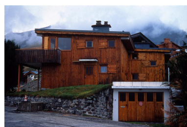
Elévation est Phot. Jean-François Lyon-Caen IVR82_19987300090ZA
