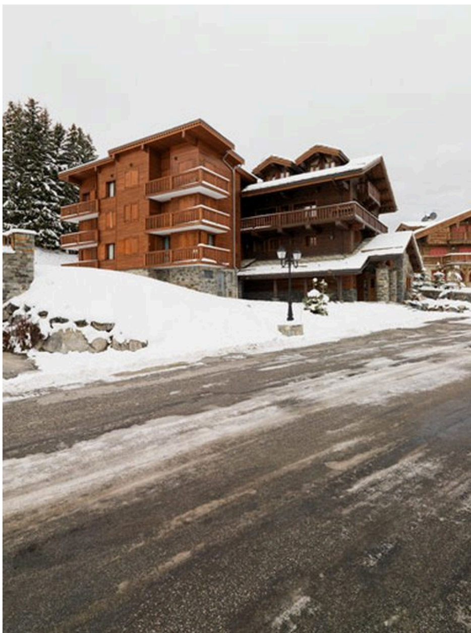
Vue d'ensemble des chalets La Forcle et Plein Ciel
