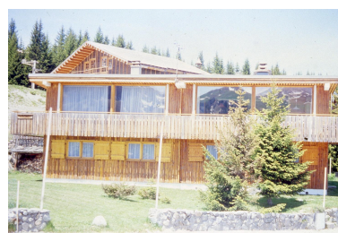
Elévation sud Phot. Jean-François Lyon-Caen IVR82_19987300089ZA
