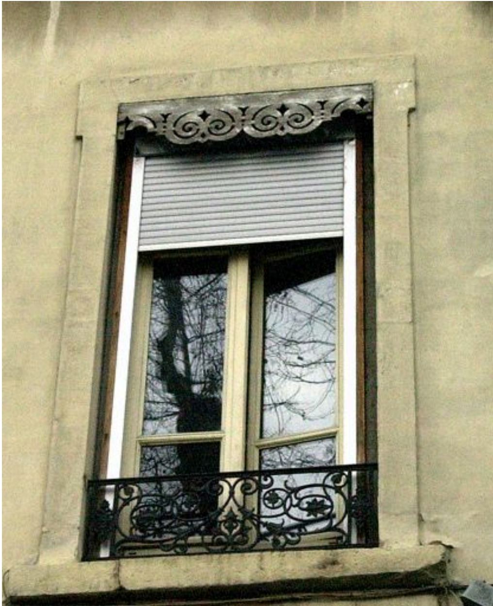
Détail d'une fenêtre, de son balconnet et de son lambrequin
