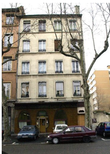
Vue générale, cours Suchet Phot. Maryannick Chalabi IVR82_20016900134NUCA
