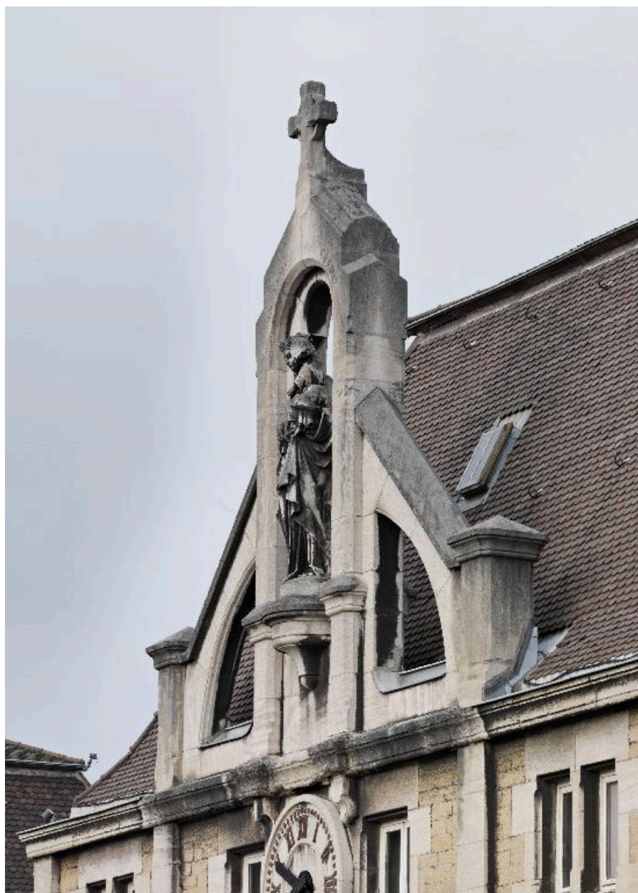
Vue d'ensemble, de 3/4 gauche
