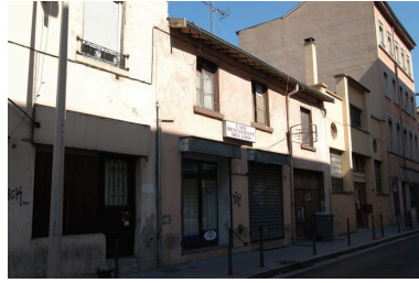
Vue générale. Phot. Catherine Guillot IVR82_20126902763NUCA
