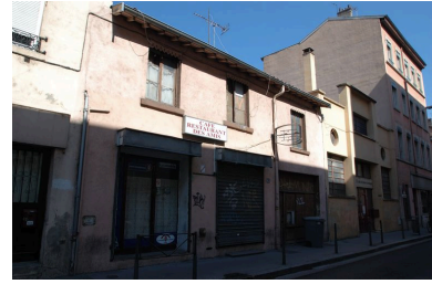
Vue générale. Phot. Catherine Guillot IVR82_20126902764NUCA
