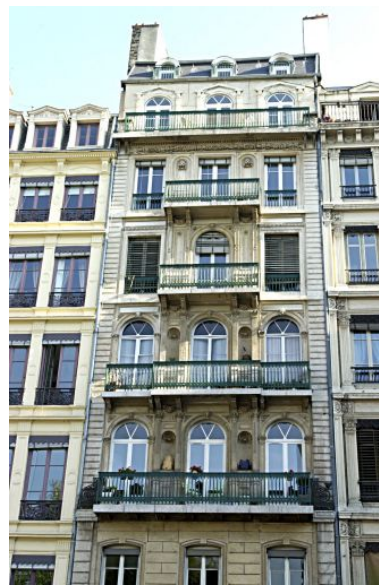
Façade sur rue, détail de l'élévation Phot. Bernard Ducouret IVR82_20046900404NUCA
