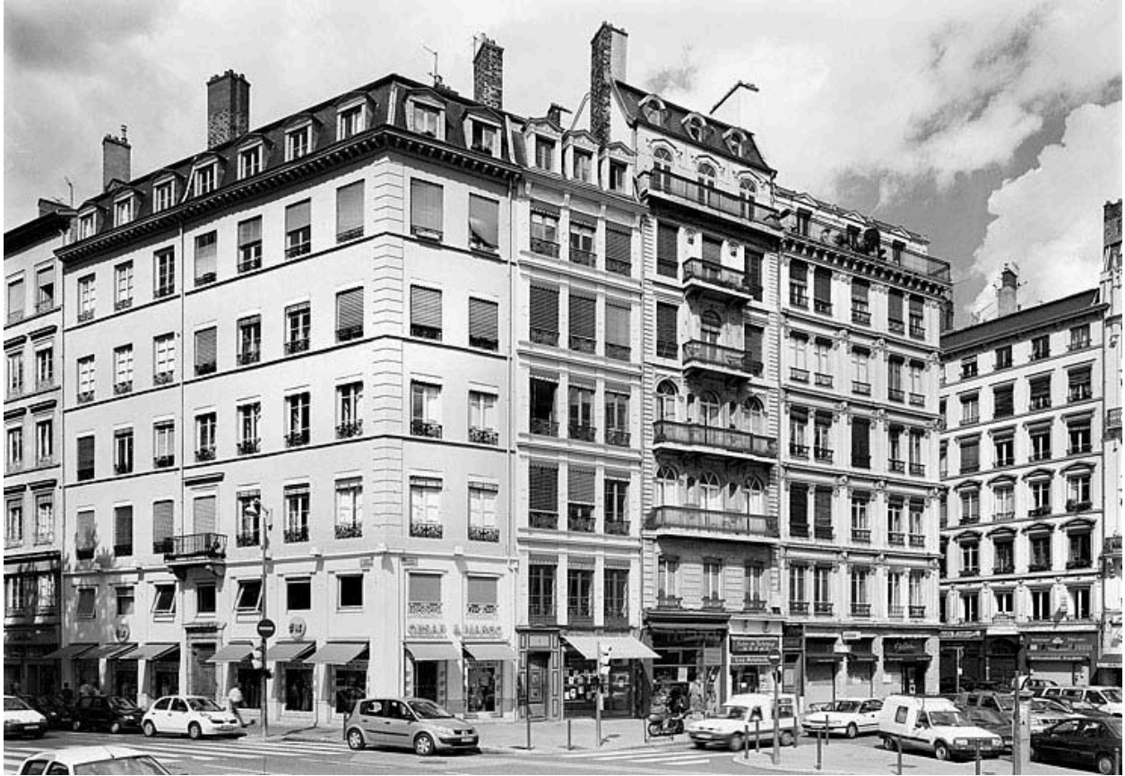
Vue générale des façades de l'îlot sur la place d'Albon
