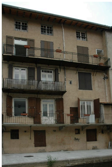
Elévation postérieure donnant sur le quai du Vizézy. Phot. Simone Hartmann-Nussbaum IVR82_20134200541NUCA
