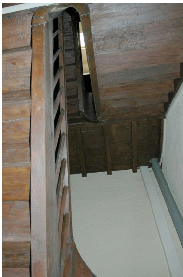
Vue partielle des volées d'escalier, du bas vers le haut. Phot. Simone Hartmann-Nussbaum IVR82_20134200543NUCA
