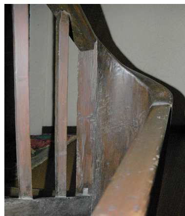
Escalier tournant à retours avec jour, détail d'un retour en bois plein. Phot. Simone Hartmann-Nussbaum IVR82_20134200542NUCA
