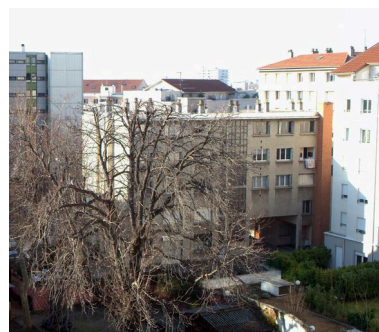
Elévation postérieure Phot. Maryannick Chalabi IVR82_20116904933NUCA
