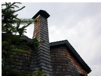
Détail de la cheminée Phot. Jean-François Lyon- Caen, Phot. C. Salomon-Pelen IVR82_20087400170NUCA
