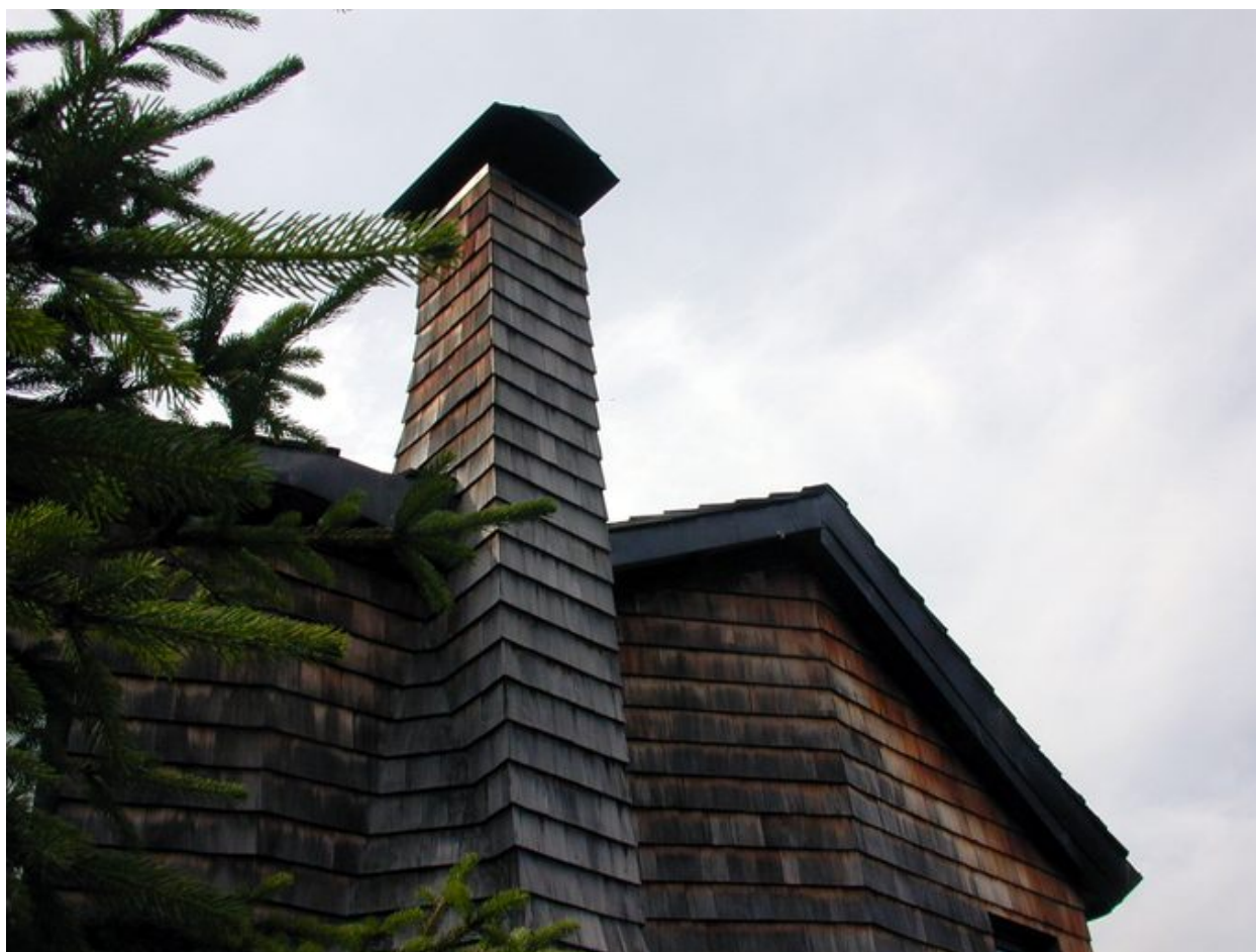
Détail de la cheminée
