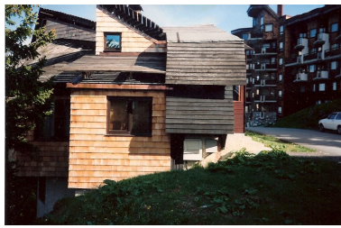
Vue de l'entrée depuis le sud. Photogr. J. Labro, 1991 (A. privées J. Labro) Phot. Jean-François Lyon- Caen, Phot. C. Salomon-Pelen, Autr. Labro Jacques (architecte) IVR82_20087400163NUC
