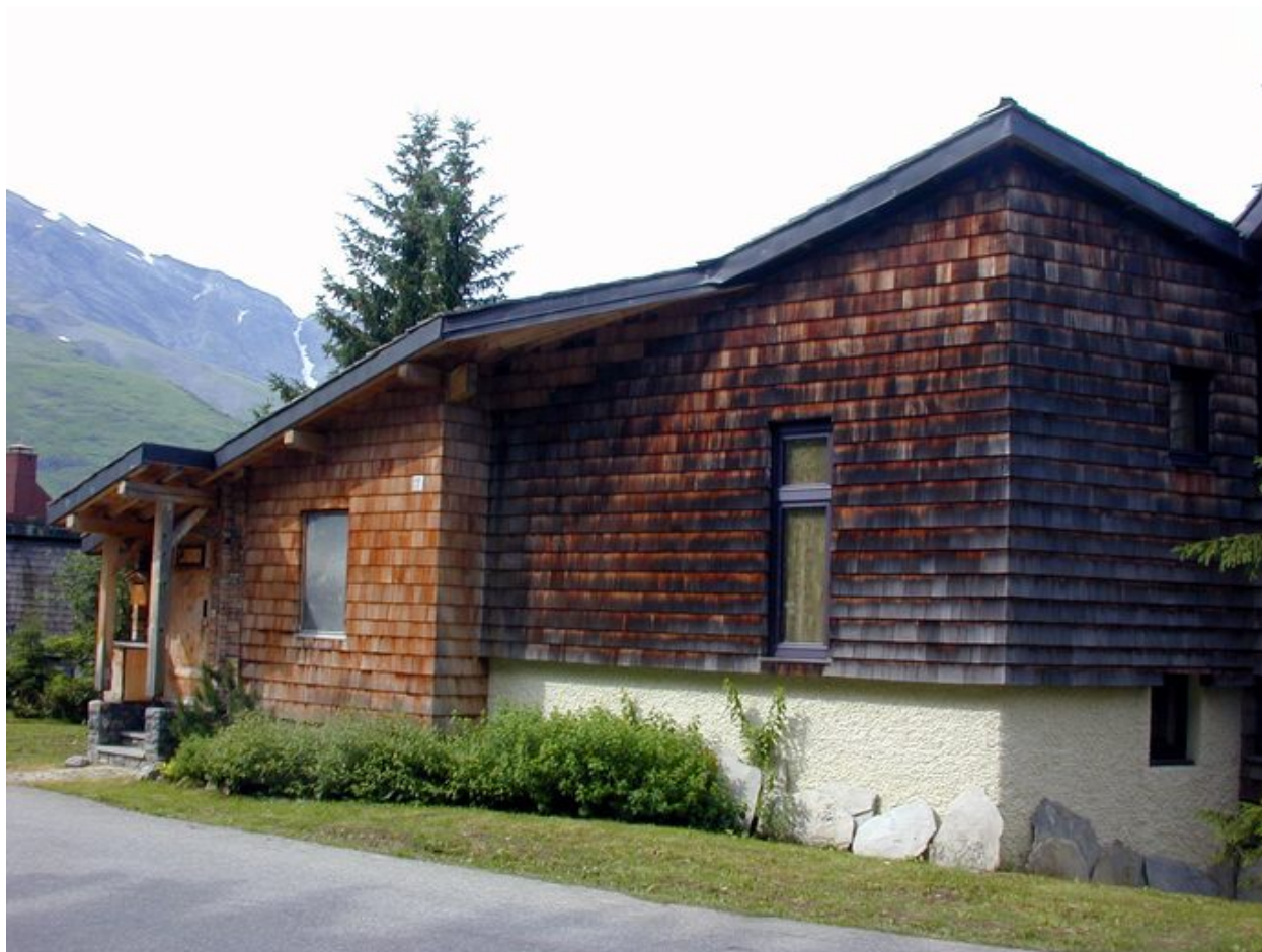
Elévation nord-est le long du chemin
