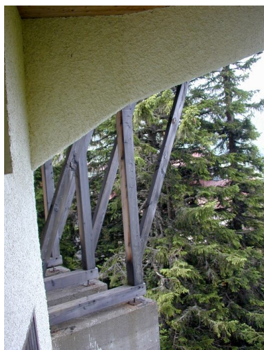
Détail des supports de l'encorbellement et du balcon Phot. Jean-François Lyon- Caen, Phot. C. Salomon-Pelen IVR82_20087400173NUCA
