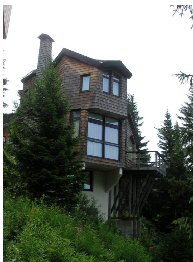
Vue d'ensemble depuis l'ouest Phot. Jean-François Lyon- Caen, Phot. C. Salomon-Pelen IVR82_20087400171NUCA
