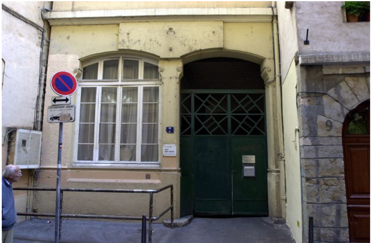
Façade sur rue, rez-de-chaussée
