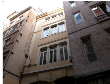
Façade sur rue, étages carrés
