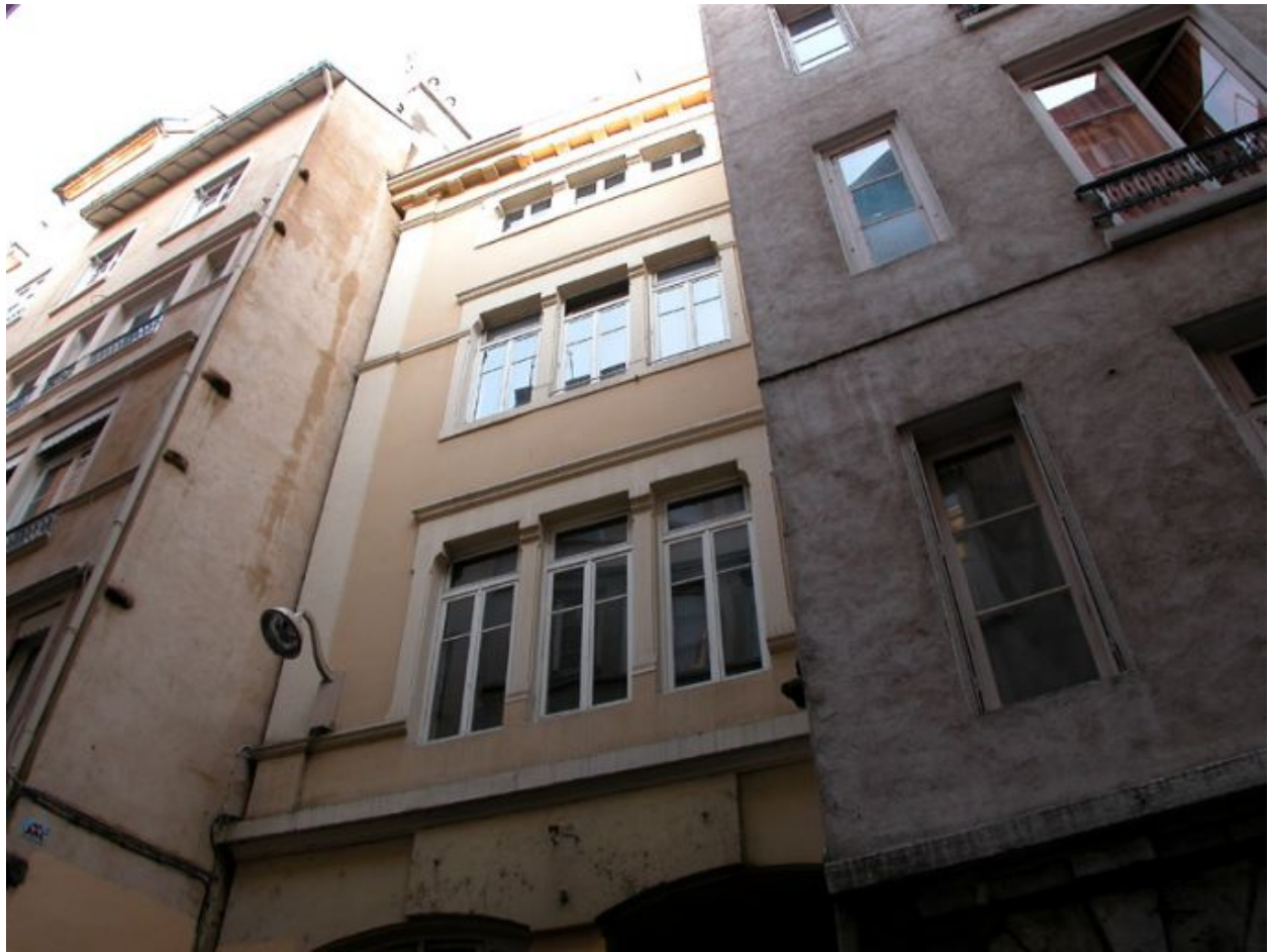
Façade sur rue, étages carrés
