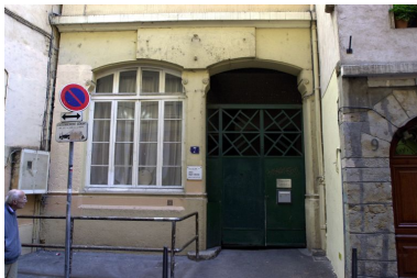
Façade sur rue, rez-de-chaussée
