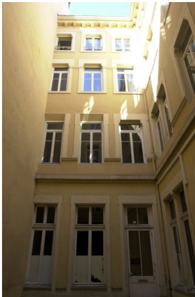
Cour, corps de gauche Phot. Bernard Ducouret IVR82_20036901283NUCA
