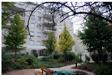
Vue de la façade arrière depuis le jardin Phot. Maryannick Chalabi IVR82_20116901568NUCA
