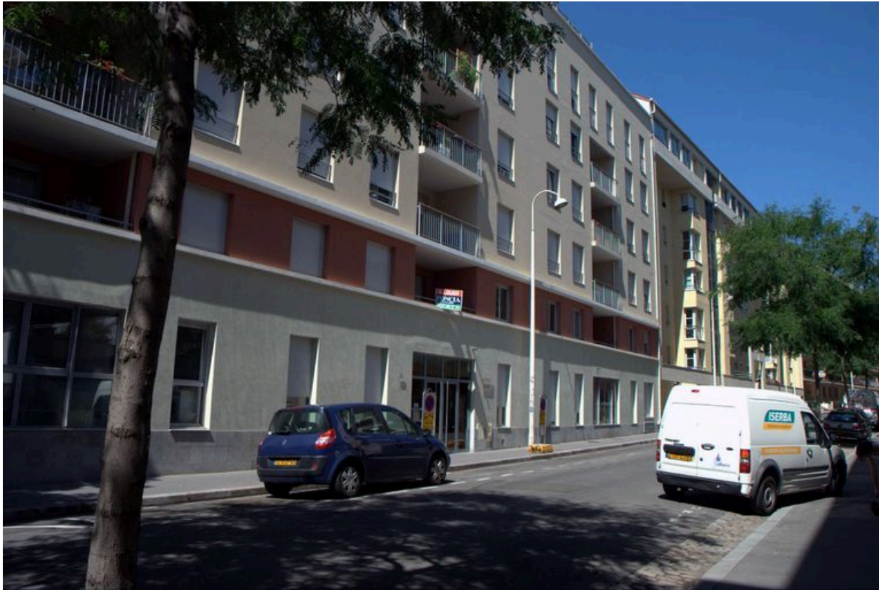
Vue d'ensemble de l'élévation antérieure
