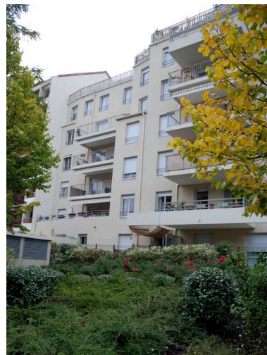
Vue de la façade arrière depuis le jardin Phot. Maryannick Chalabi IVR82_20116901569NUCA
