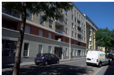
Vue d'ensemble de l'élévation antérieure Phot. Maryannick Chalabi IVR82_20116901516NUCA
