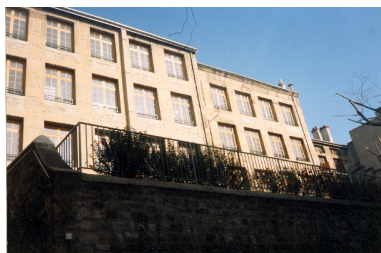
Façade principale Phot. Cendrine Sanquer IVR82_19974202078ZE
