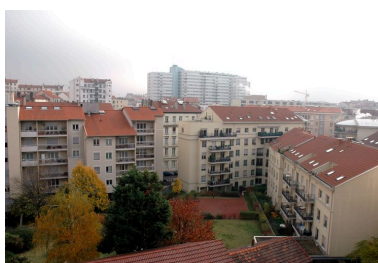
Elévation postérieures et jardin Phot. Maryannick Chalabi IVR82_20076900381NUCA
