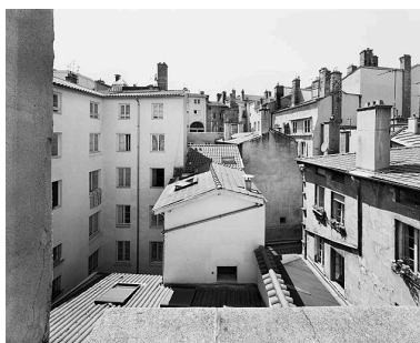
Bâtiment 3, façade postérieure (1er plan à droite) vue depuis le toit du temple mitoyen Phot. Eric Dessert IVR82_20046900557V
