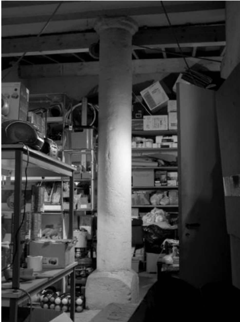
Bâtiment 2, colonne supportant l'ouverture sud sur la cour 2 (aujourd'hui couverte)
