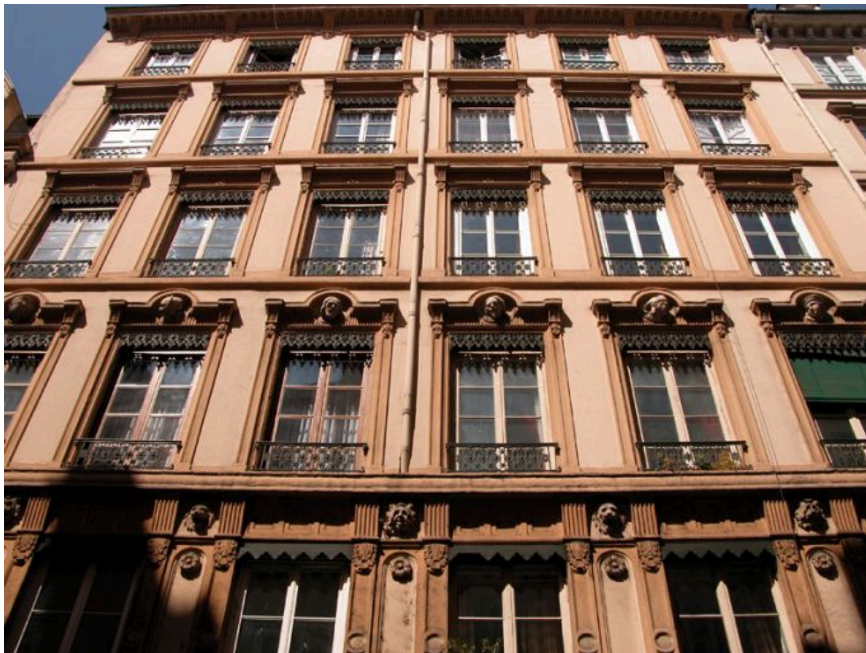
Bâtiment 1, façade sur la rue Lanterne
