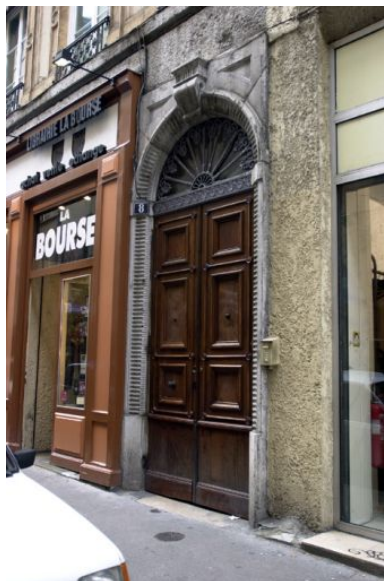
Bâtiment 1, façade sur la rue Lanterne, porte Phot. Bernard Ducouret IVR82_20056902677NUCA
