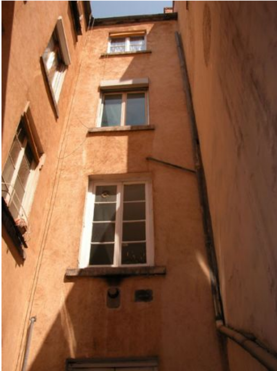
Bâtiment 2, élévation est sur la cour II
