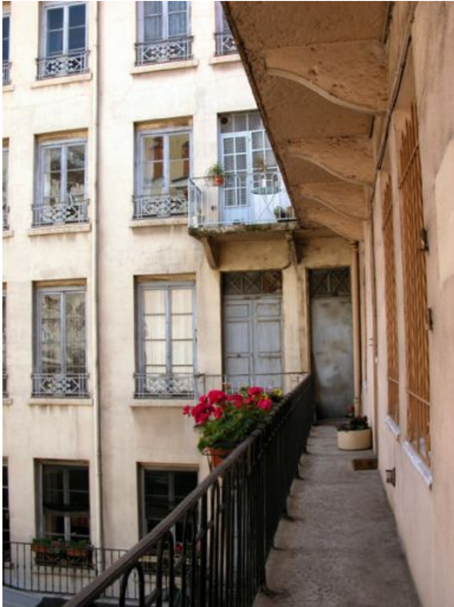
Bâtiment 3, coursière du 2e étage
