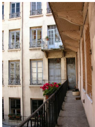
Bâtiment 3, coursière du 2e étage Phot. Phot. Inv. D. Chevallier IVR82_20046900672NUCA
