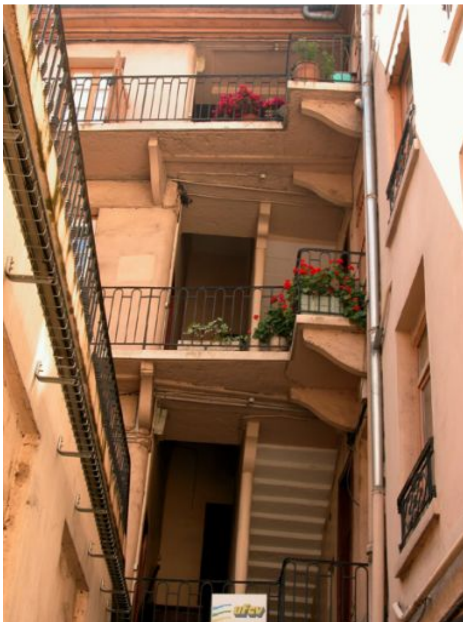
Bâtiment 3 vu depuis la cour III, élévation des niveaux 2 à 4 de la cage d'escalier
