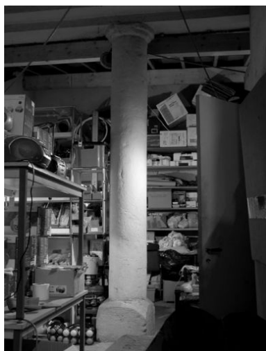
Bâtiment 2, colonne supportant l'ouverture sud sur la cour 2 (aujourd'hui couverte) Phot. Phot. Inv. D. Chevallier IVR82_20046900664NUCA
