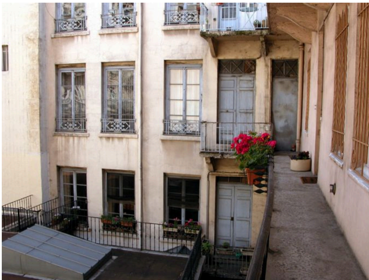
Bâtiment 2, façade sur la cour III, élévation des 2e et 3e niveaux
