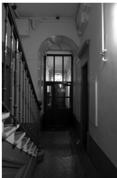
Bâtiment 1, allée vue depuis l'escalier Phot. Bernard Ducouret IVR82_20056902680NUC
