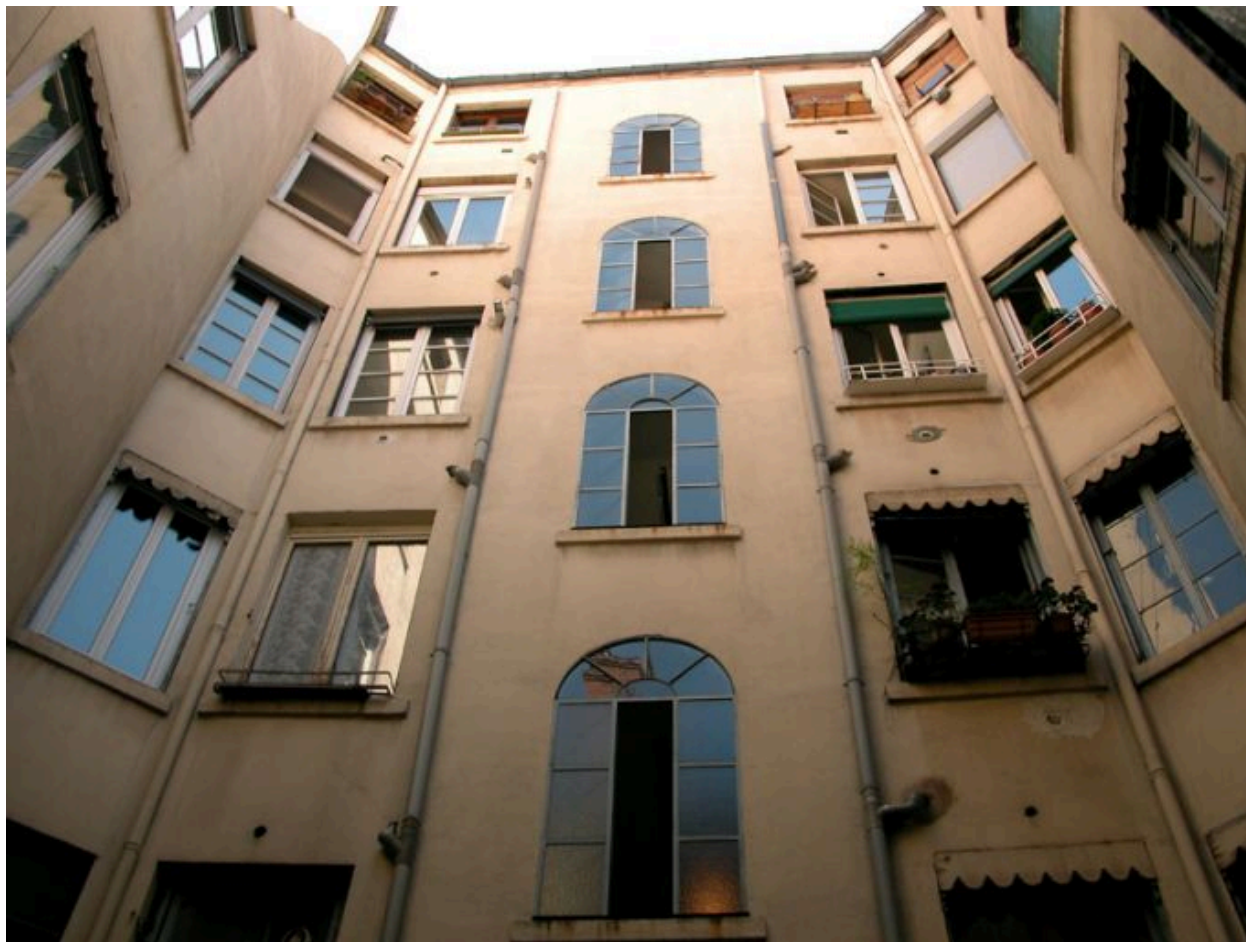
Bâtiment 1, façade sur la cour I, vue à partir des fenêtres du 4e niveau
