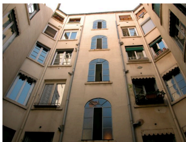
Bâtiment 1, façade sur la cour I, vue à partir des fenêtres du 4e niveau Phot. Phot. Inv. D. Chevallier IVR82_20046900661NUCA
