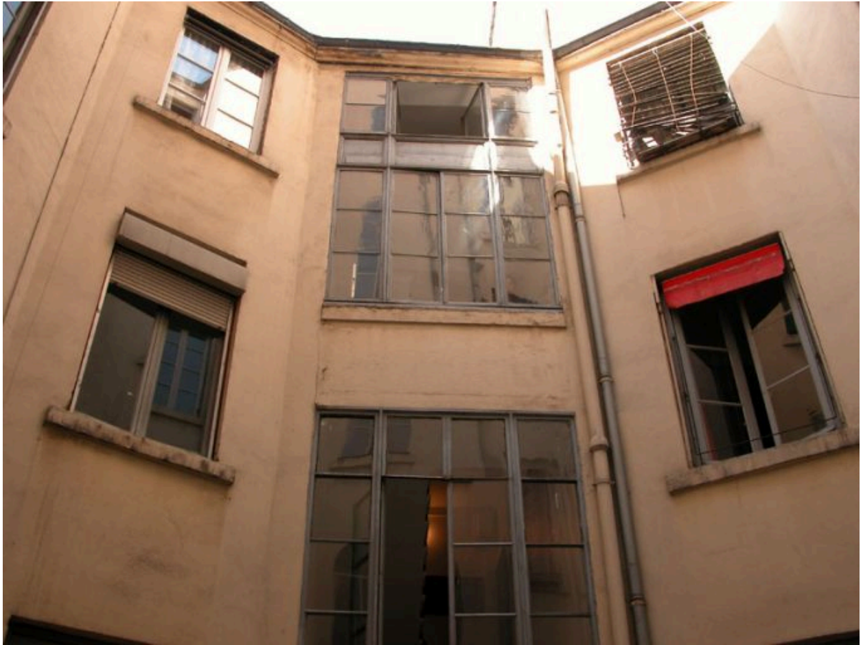
Bâtiment 2, élévation sur la cour I, partie supérieure
