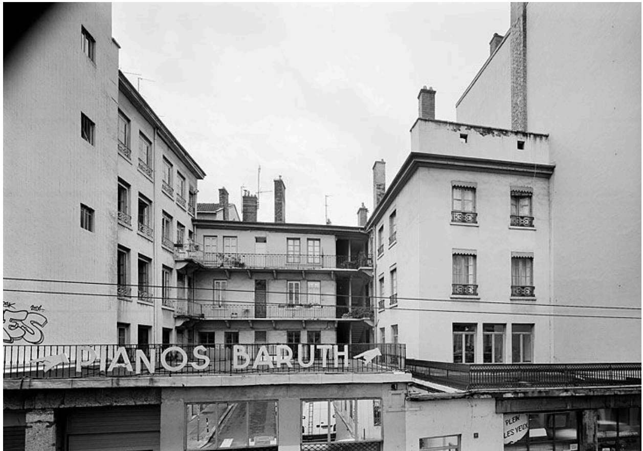
Bâtiment 2, 3 et 4, vue générale depuis la rue Constantine
