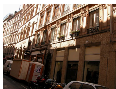
Bâtiment 1, façade sur la rue Lanterne, détail des 2 premiers niveaux Phot. Inv. D. Chevallier IVR82_20046900658NUCA
