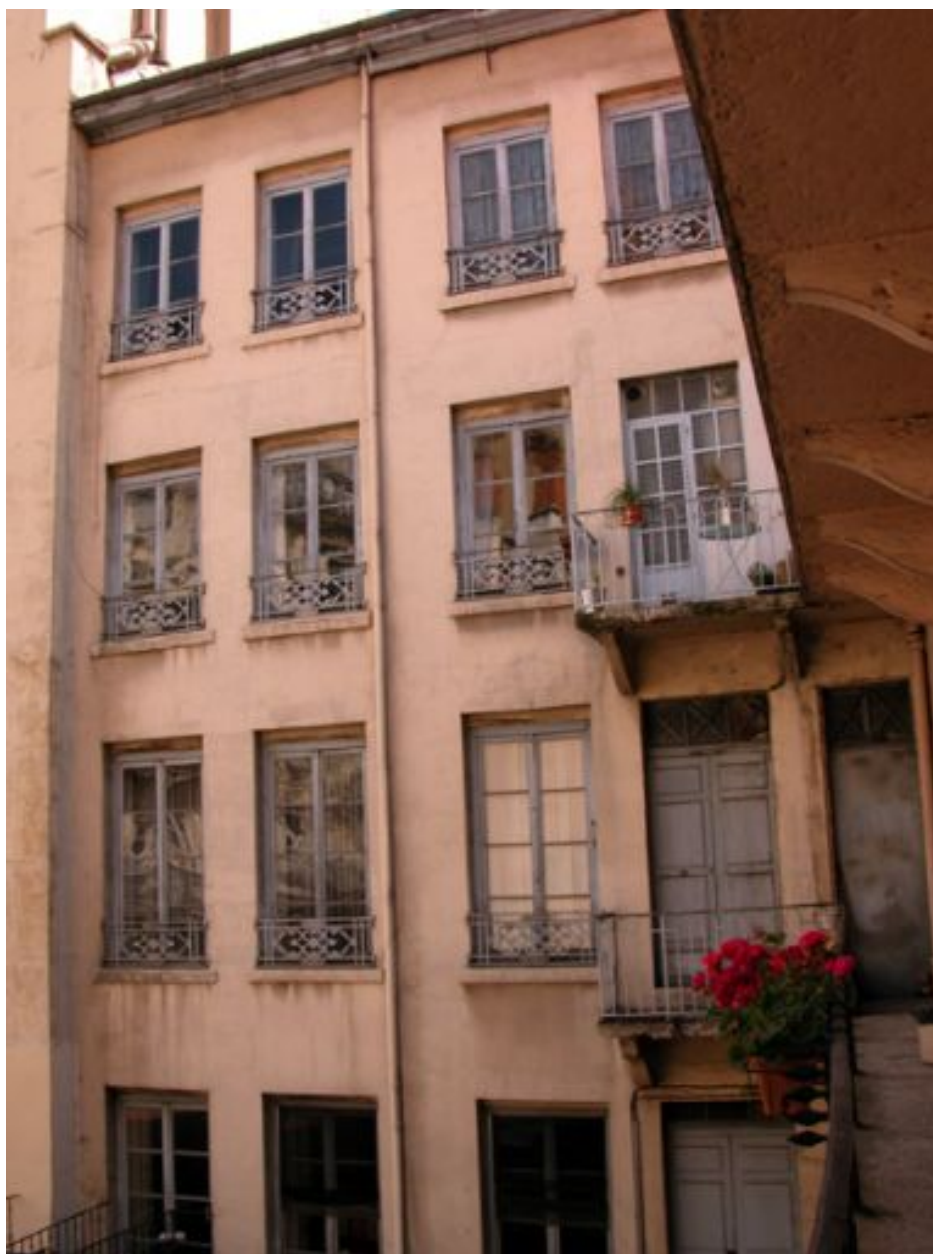
Bâtiment 2, façade sur la cour III, élévation des niveaux 3 à 5
