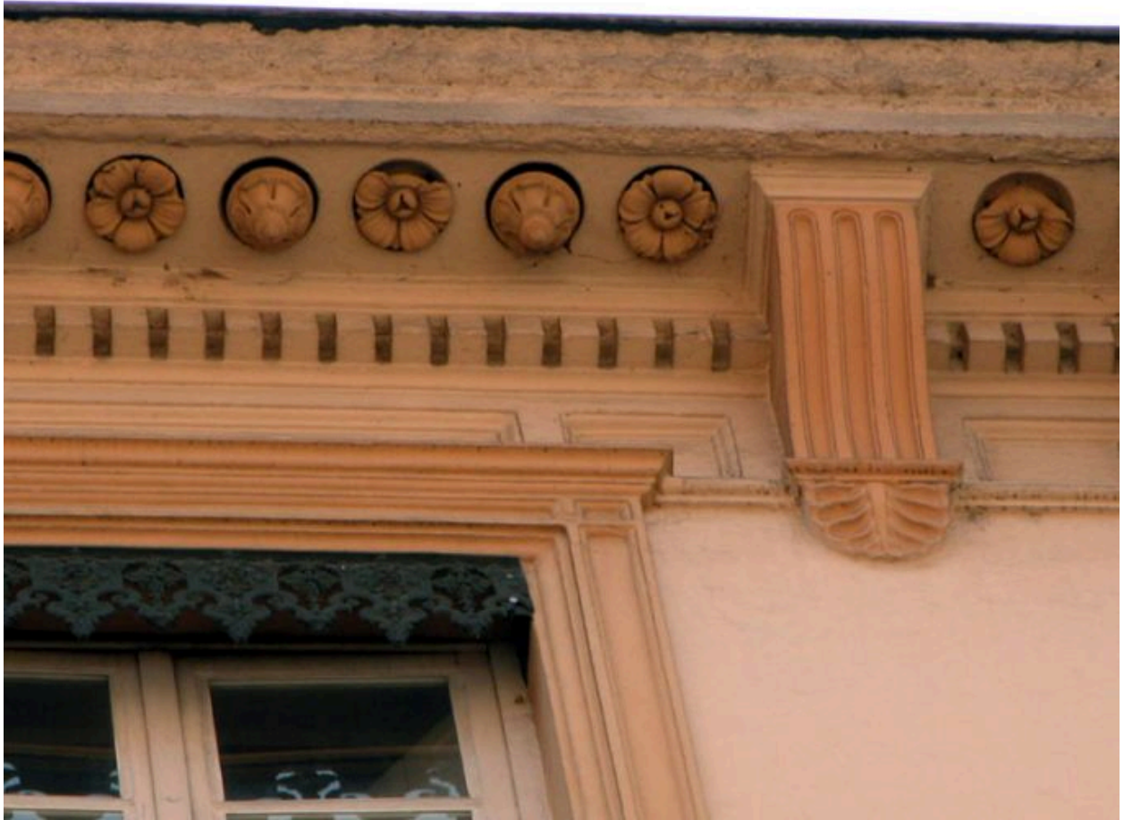
Bâtiment 1, façade sur rue, détail de la corniche
