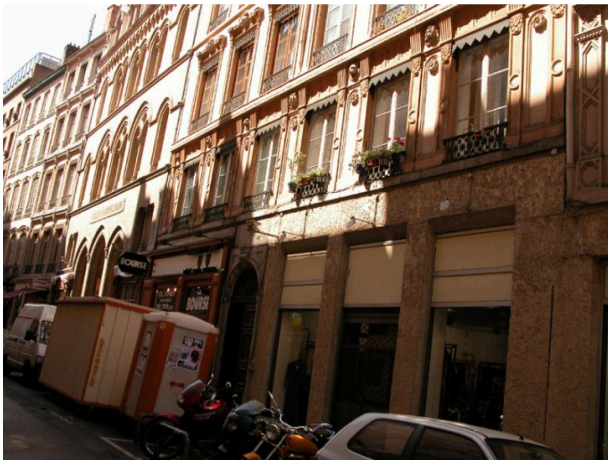
Bâtiment 1, façade sur la rue Lanterne, détail des 2 premiers niveaux
