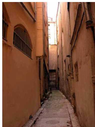
Ancienne entrée au fond de l'impasse du 2, quai de la Pêcherie Phot. Phot. Inv. D. Chevallier IVR82_20046900674NUCA
