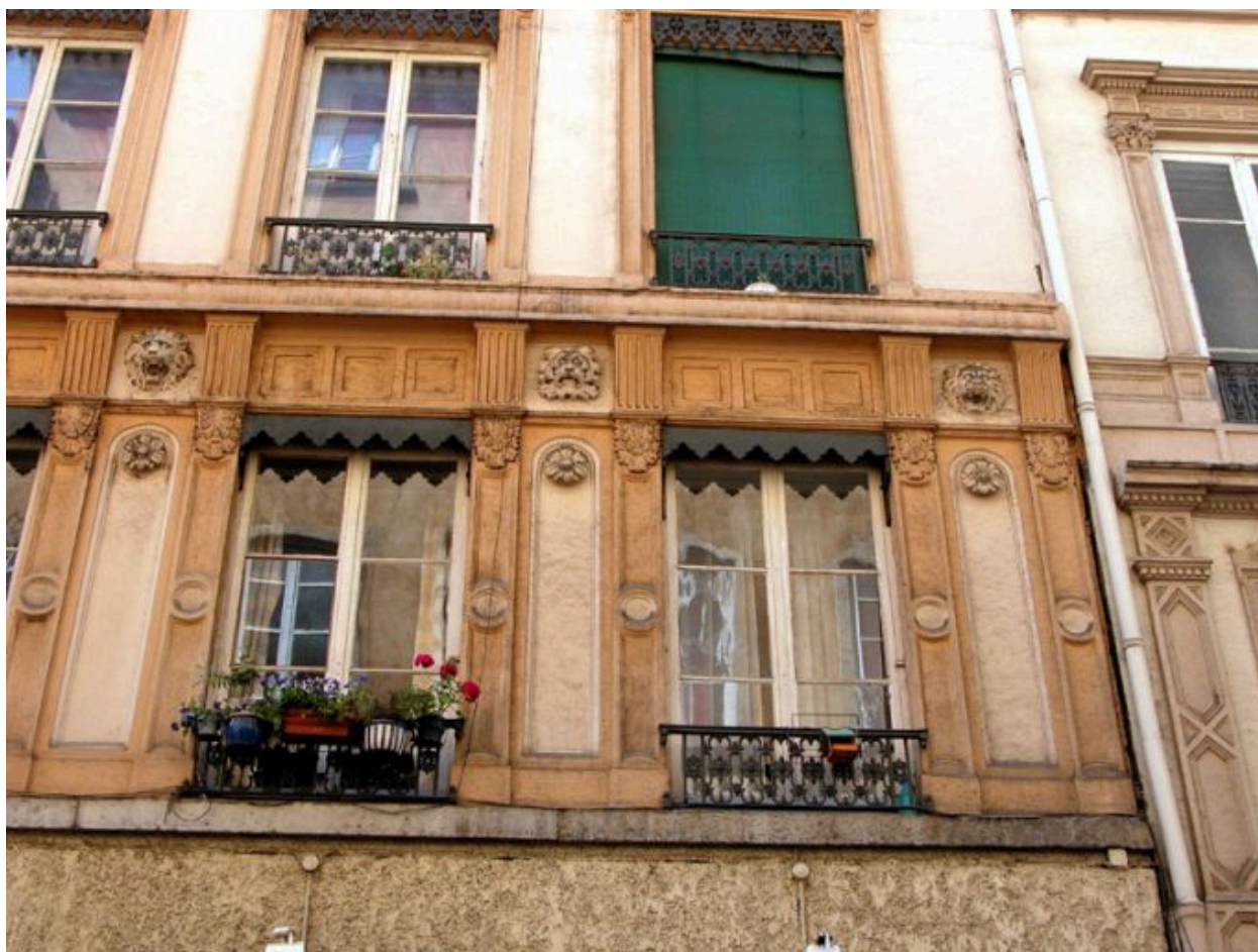
Bâtiment 1, façade sur rue, détail du 2e niveau
