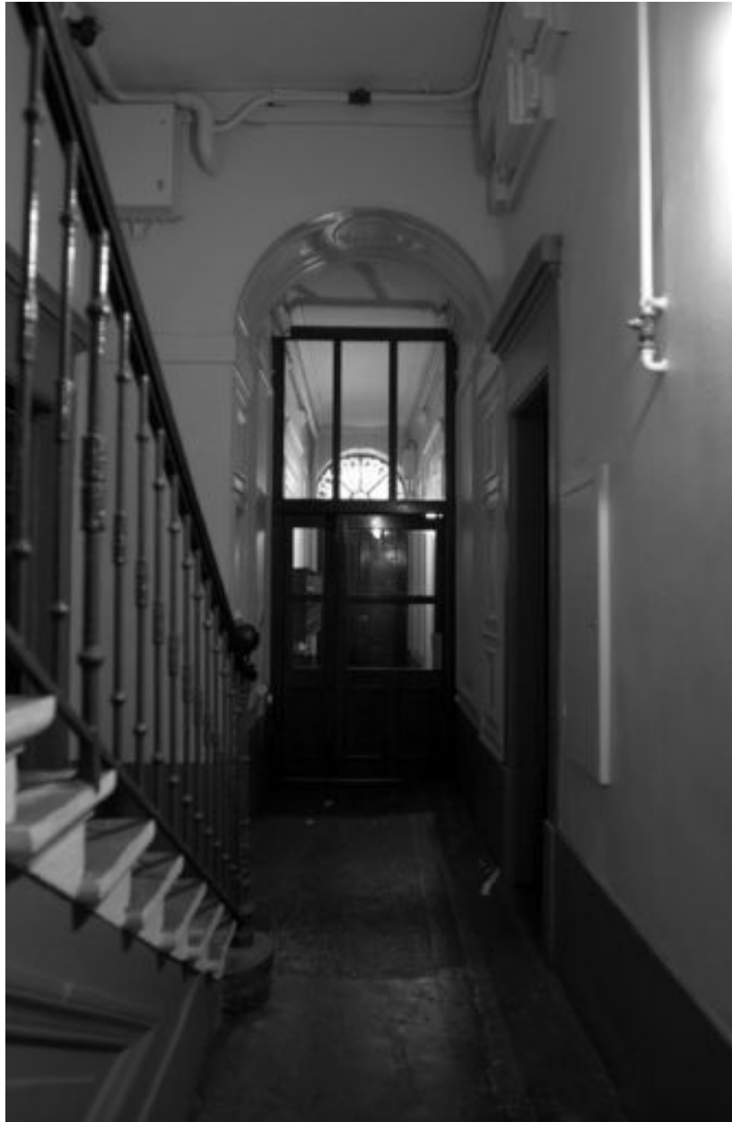
Bâtiment 1, allée vue depuis l'escalier
