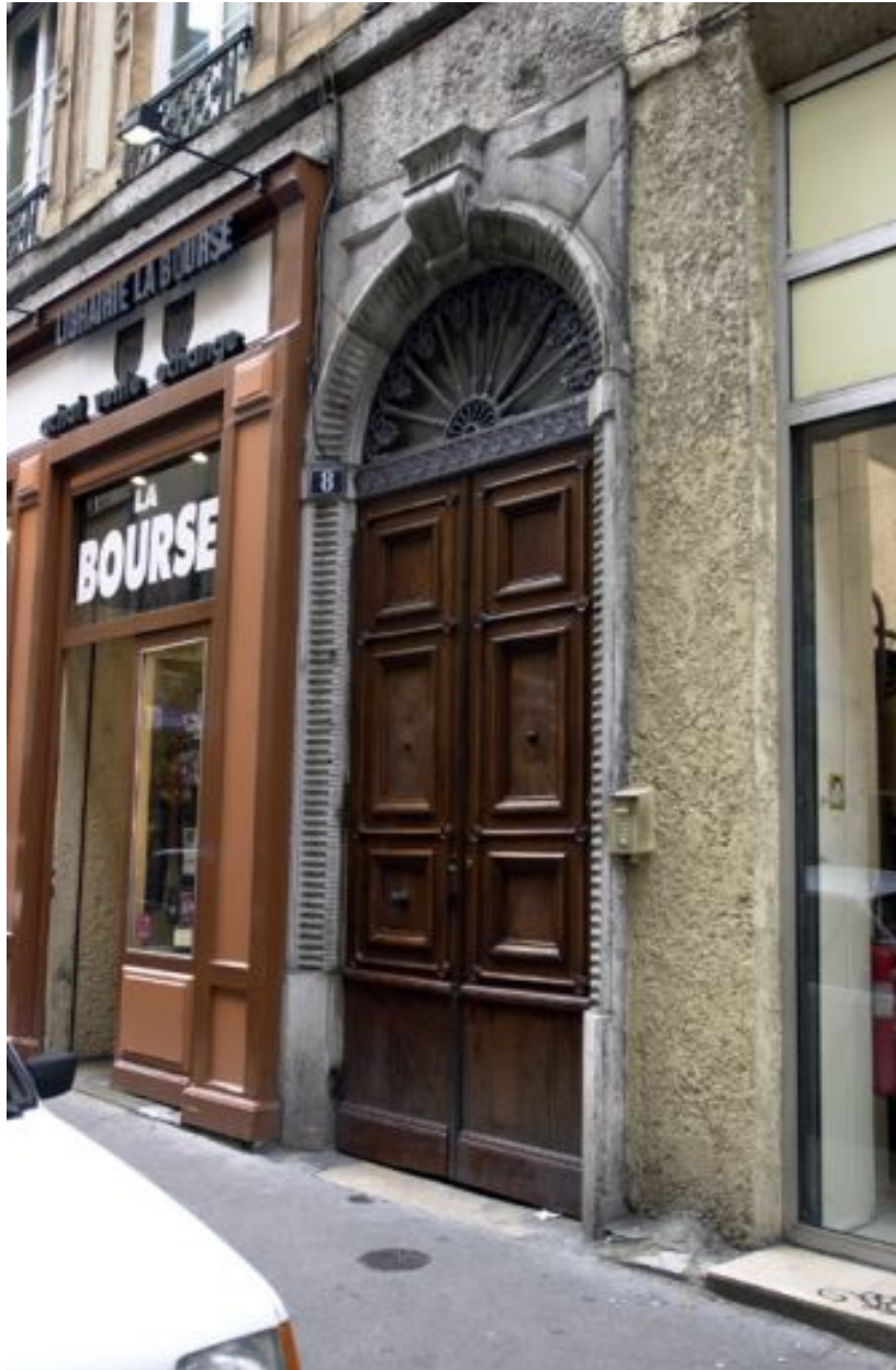
Bâtiment 1, façade sur la rue Lanterne, porte
