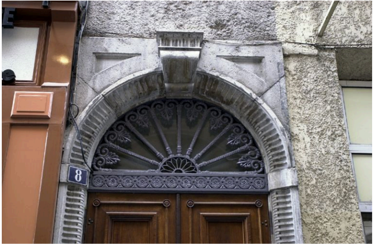
Bâtiment 1, façade sur la rue Lanterne, porte, détail du tympan de ferronnerie
