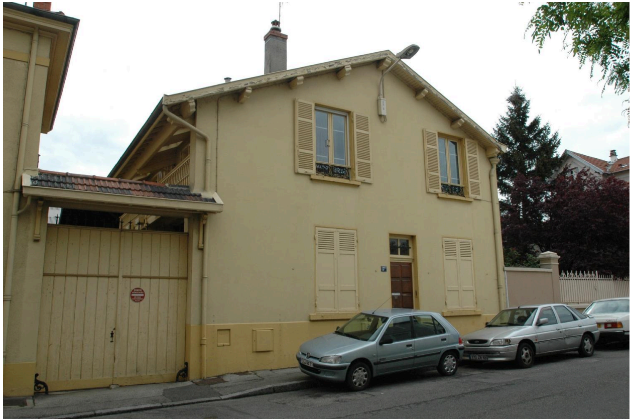
Façade principale Usine rue Girie
