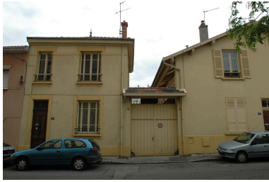
Façade principale usine rue Girie Phot. Nadine Halitim-Dubois IVR84_20246901152NUCA
