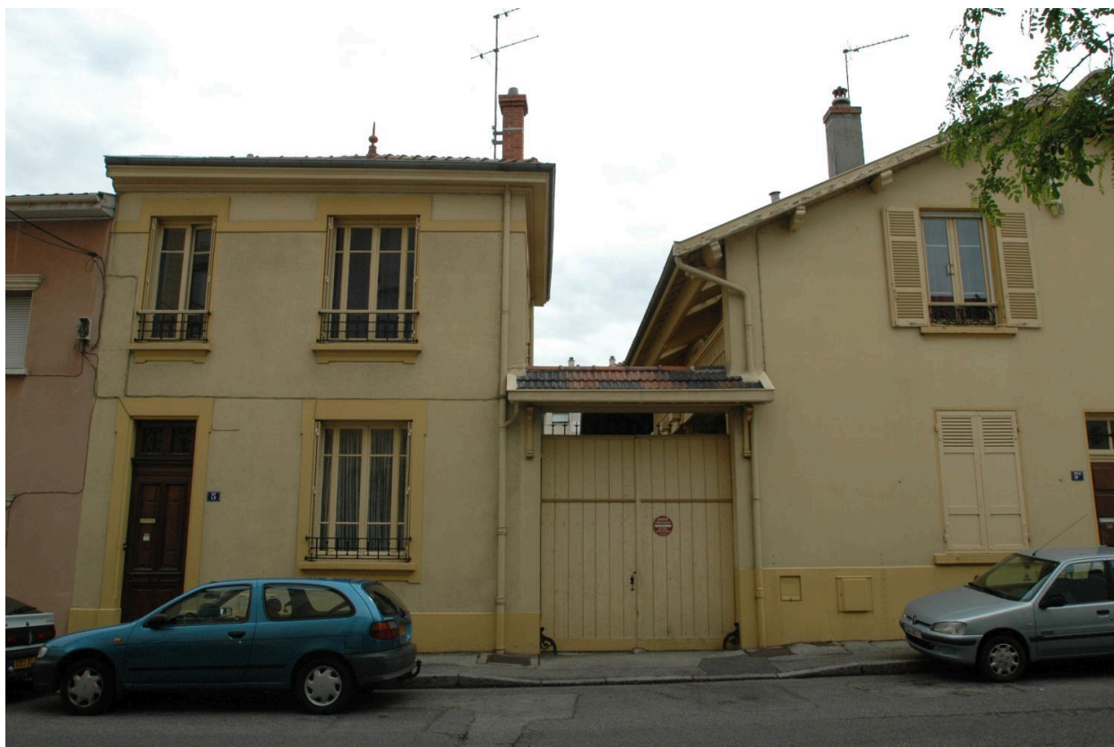
Façade principale usine rue Girie
