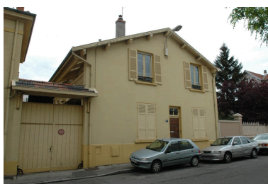
Façade principale Usine rue Girie Phot. Nadine Halitim-Dubois IVR84_20246901150NUCA
