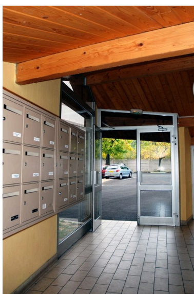
Hall d'entrée Phot. Maryannick Chalabi IVR82_20116901554NUCA
