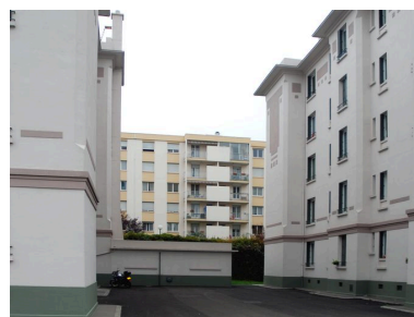
Vue entre les deux immeubles depuis le sud ouest Phot. Maryannick Chalabi IVR82_20116901548NUCA
