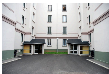
Vue des entrées d'un des deux immeubles Phot. Maryannick Chalabi IVR82_20116901553NUCA
