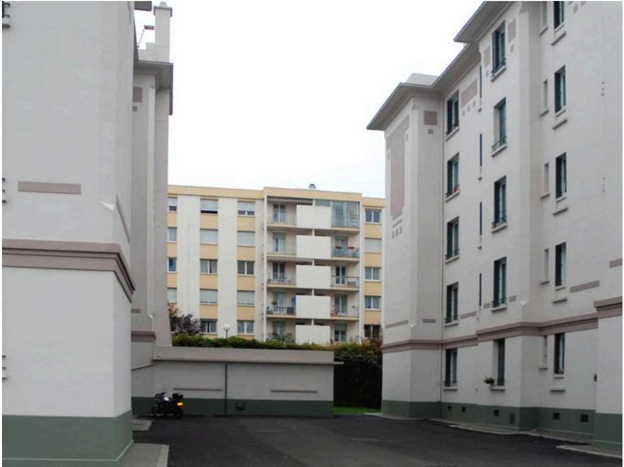
Vue entre les deux immeubles depuis le sud ouest
