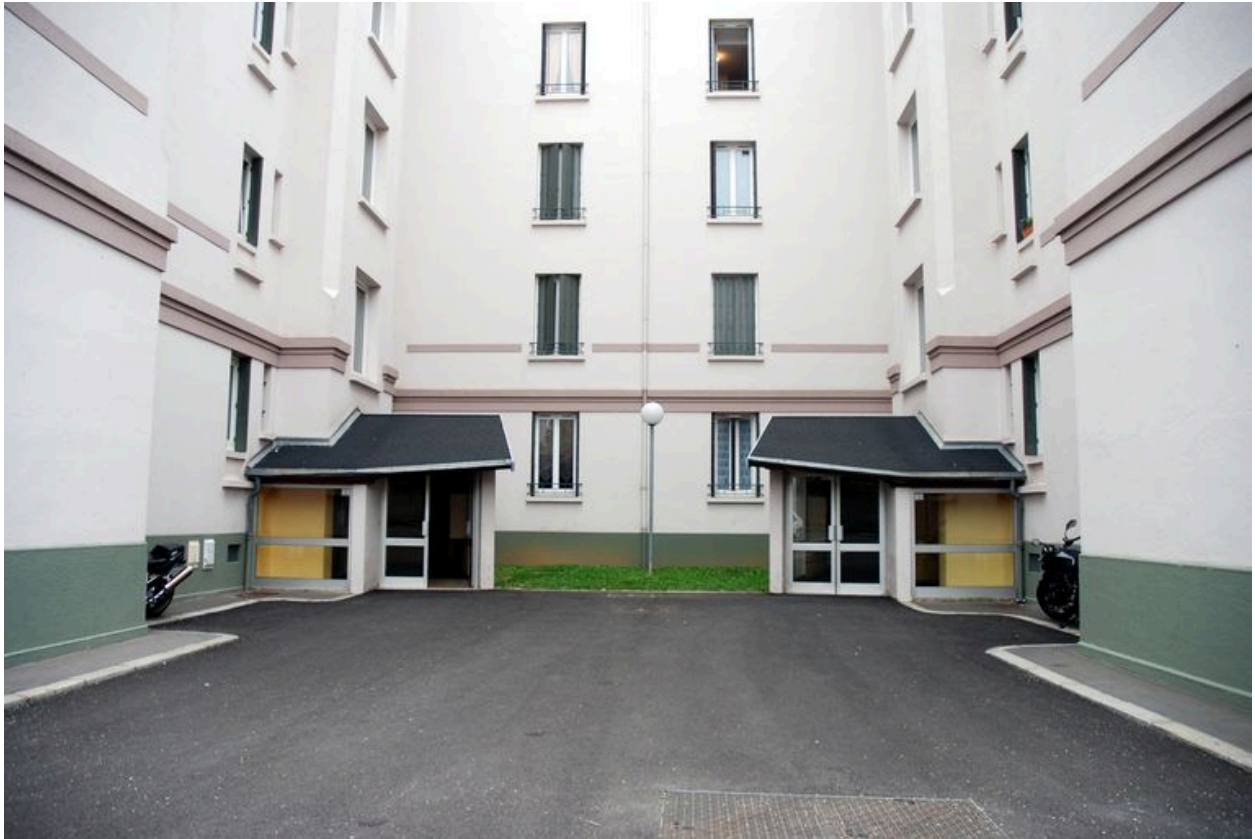
Vue des entrées d'un des deux immeubles
