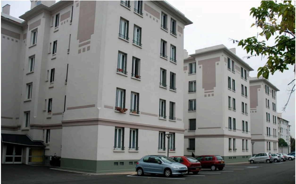
Vue des élévations depuis le sud ouest
