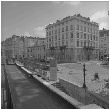
Vue d'ensemble Phot. Eric Dessert IVR82_20076902247X
