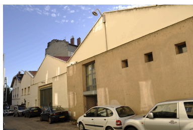
Façade sud Phot. Nadine Halitim-Dubois IVR82_20106900499NUCA
