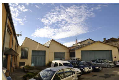
Vue d'ensemble est Phot. Nadine Halitim-Dubois IVR82_20106900496NUCA
